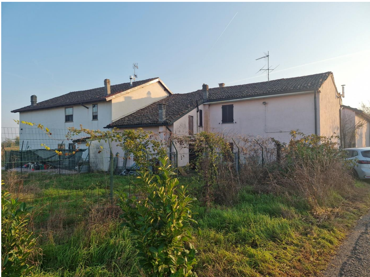
FOTO 2 – Vista esterna lato Nord – CORPO A+B
