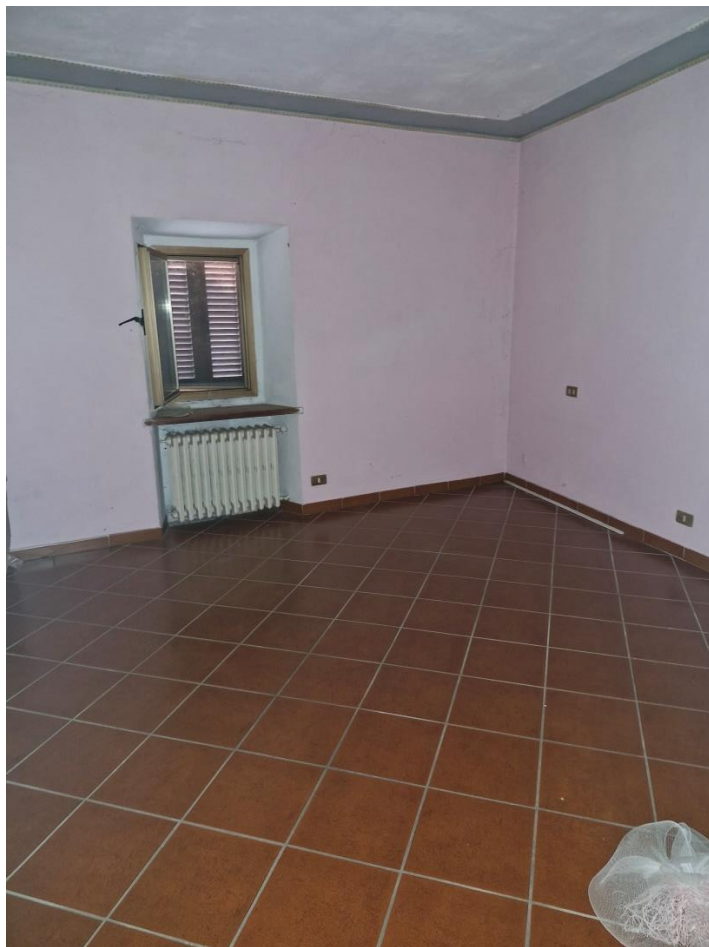
FOTO 10 – Camera al primo piano – CORPO A
