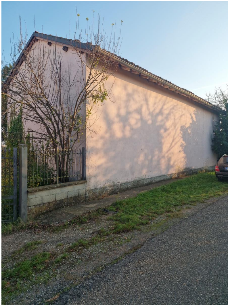
FOTO 3 – Vista lato strada locali pertinenziali - CORPO A
