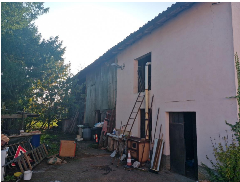
FOTO 4 – Vista lato cortile locali pertinenziali - CORPO A
