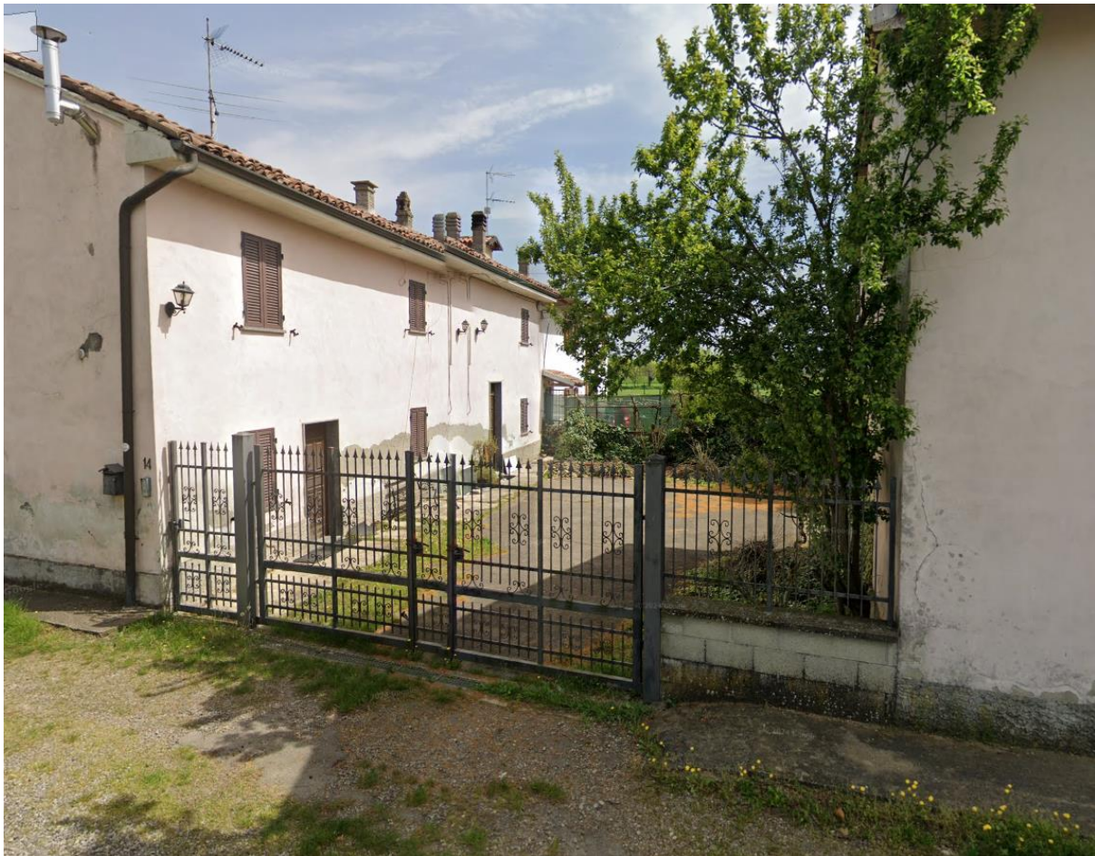
FOTO 1 – Vista esterna dalla strada di accesso – CORPO A
