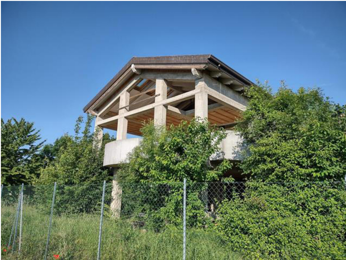
FOTO 3. Fabbricato in costruzione: prospetto laterale Nord-Ovest
