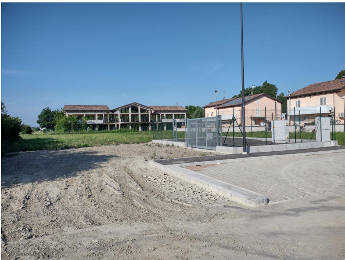
FOTO 1. Fabbricato in costruzione da Via Sisa e parte dei terreni da cedere ai Comune di Forlì
