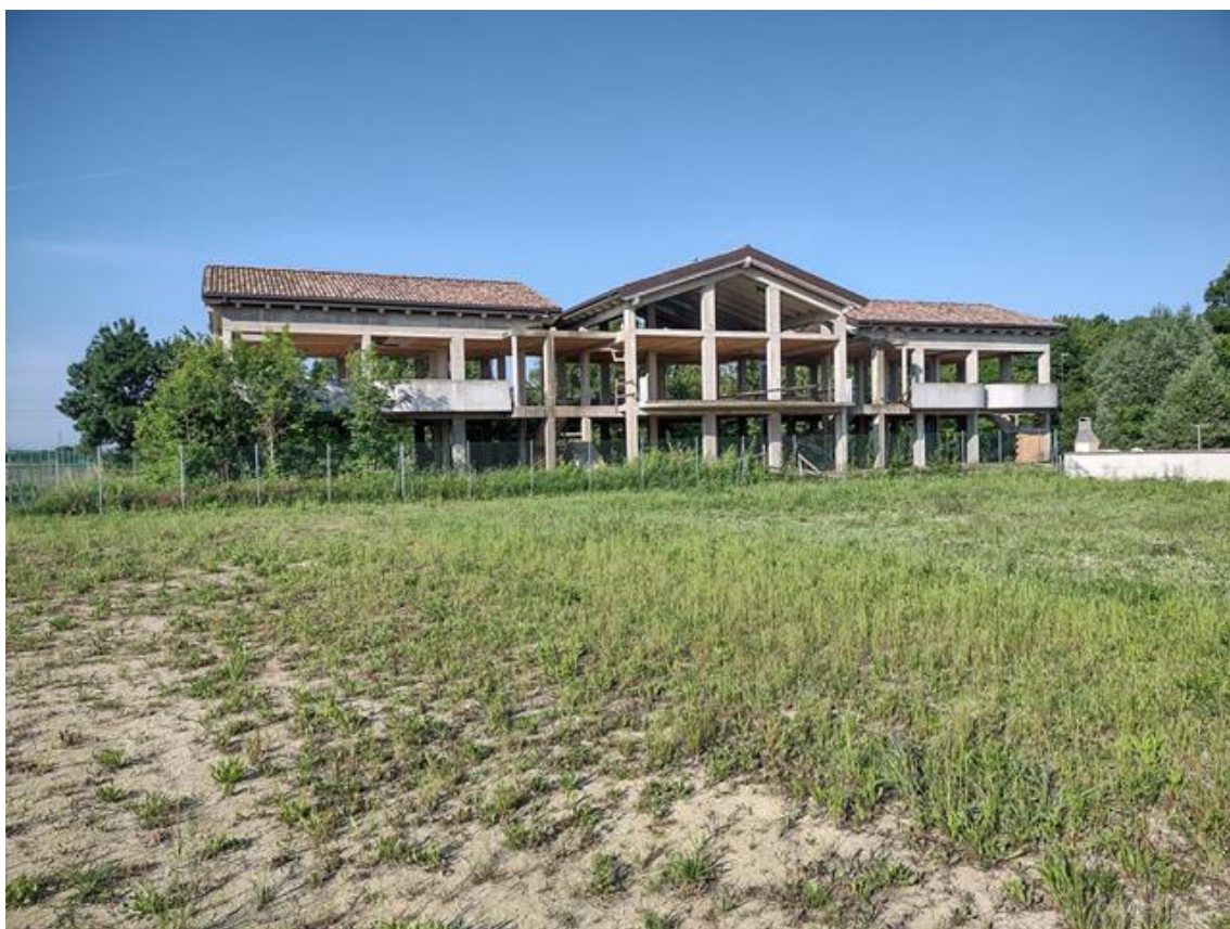
FOTO 2. Fabbricato in costruzione: fronte Nord-Est.
