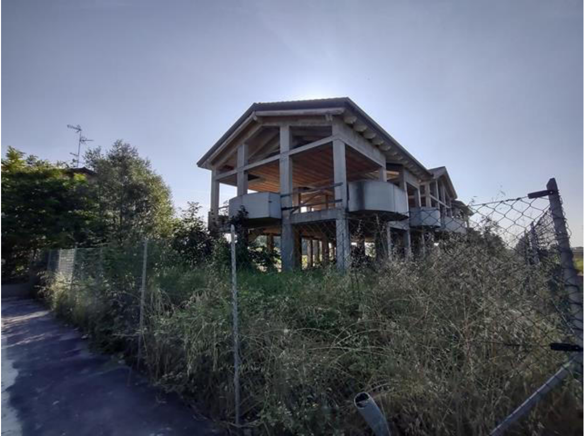
FOTO 5. Fabbricato in costruzione: prospetto laterale Sud-Est
