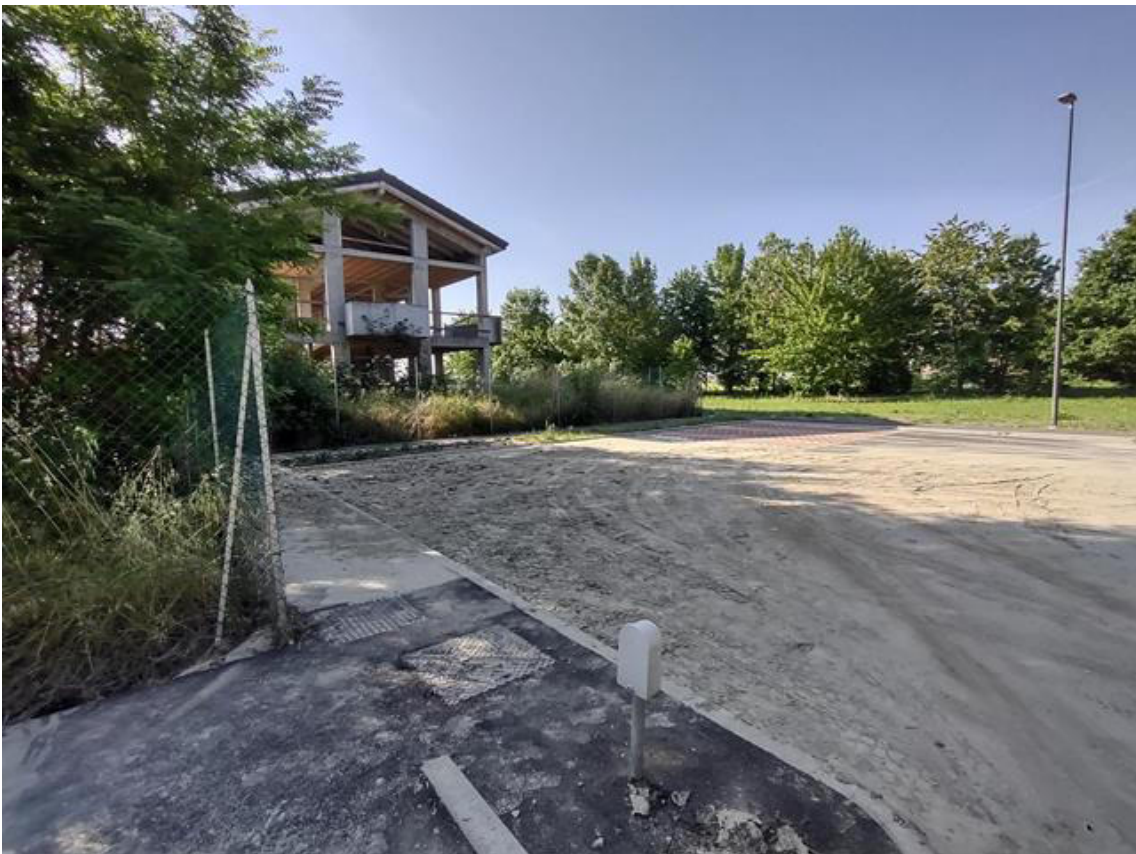
FOTO 10. Particelle di terreno da cedere al Comune di Forlì: ora parcheggio al termine di Via Rassone
