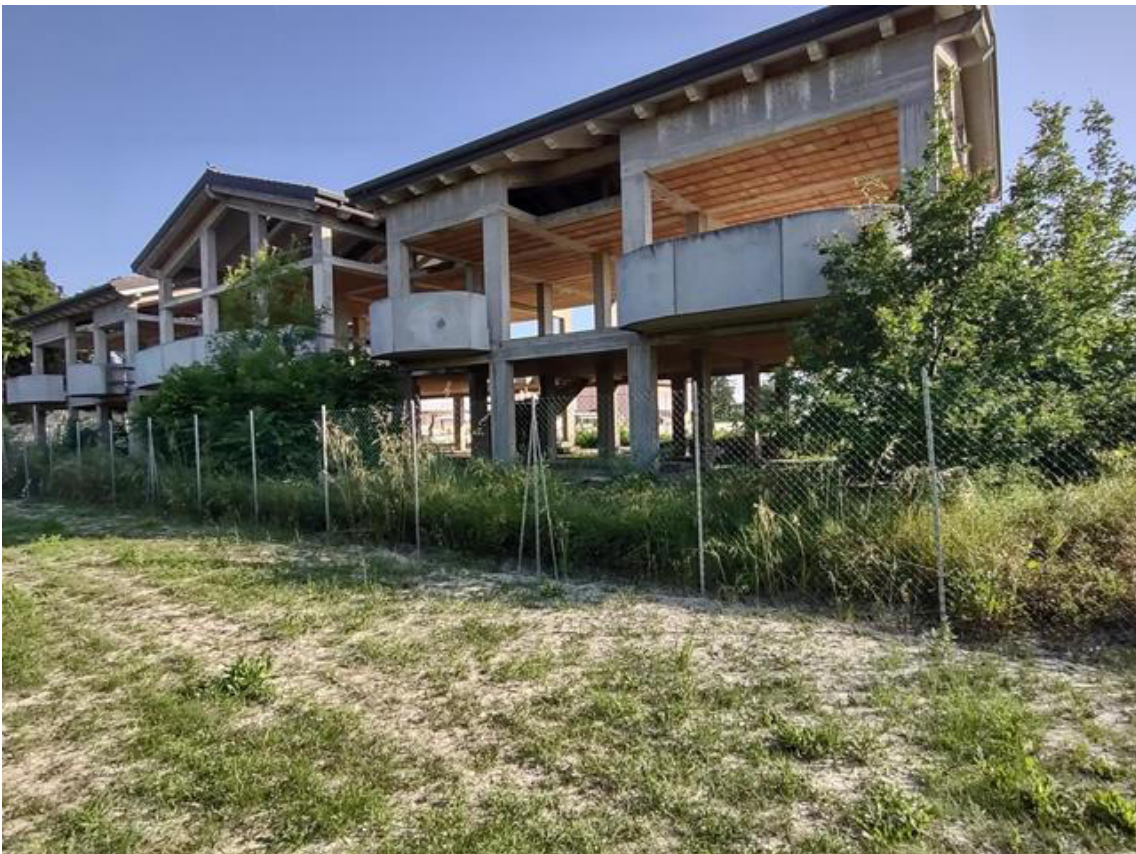
FOTO 4. Fabbricato in costruzione: prospetto Nord-Est
