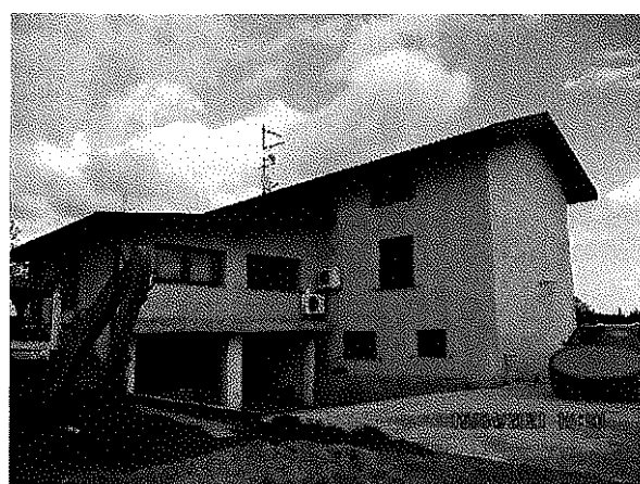
Fabbricato vista dal cortile interno
