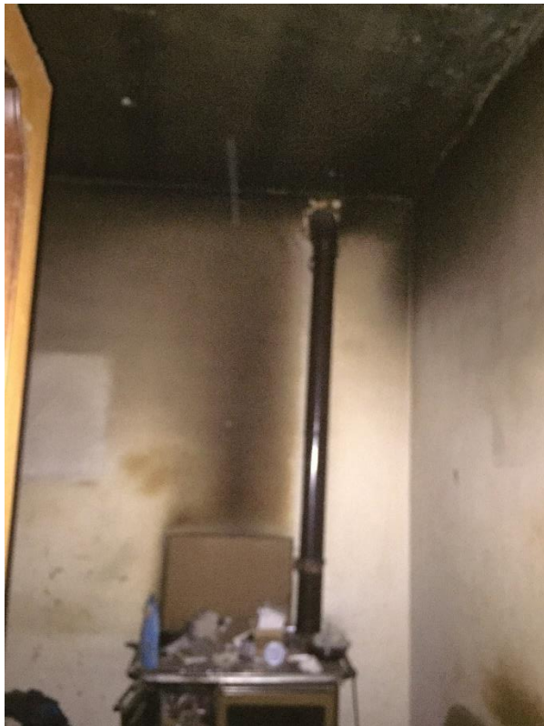
Vano piano primo
