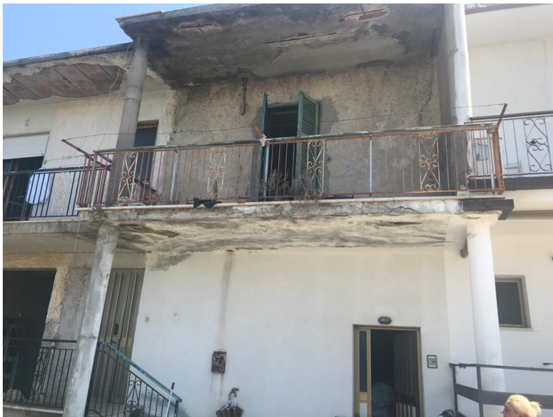
Vista balcone e facciata piano primo
