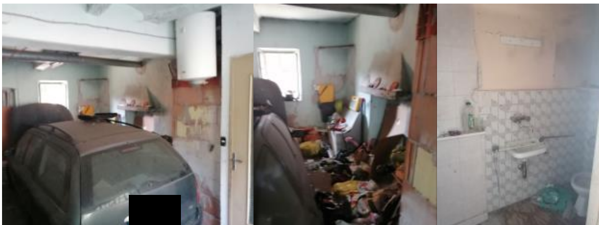
VISTA RIPOSTIGLIO E SERVIZIO IGIENICO AL P.T.
