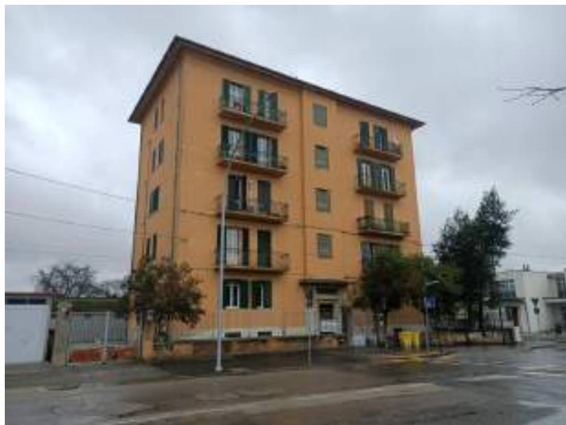
Fronte su Via A.Volta n.41 e retro verso ferrovia
