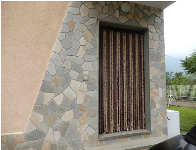
Porta di accesso sub. 5 p.t. in comune con altra u.i.
