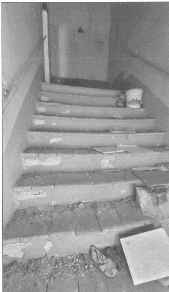
Foto 11: scala di accesso al piano secondo
