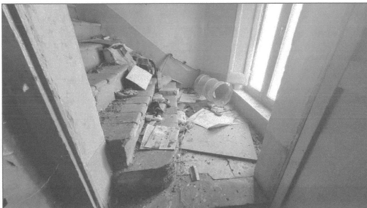
Foto 12: scala dal piano primo al secondo
