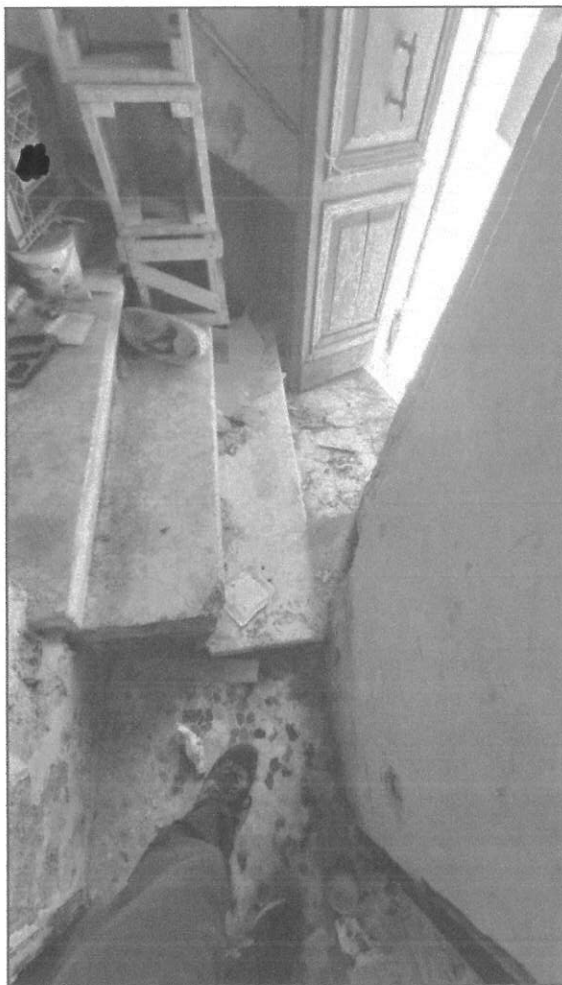
Foto 19: accesso al piano terra
