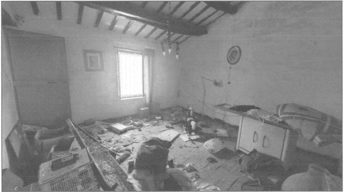
Foto 4: camera 1 al piano secondo
