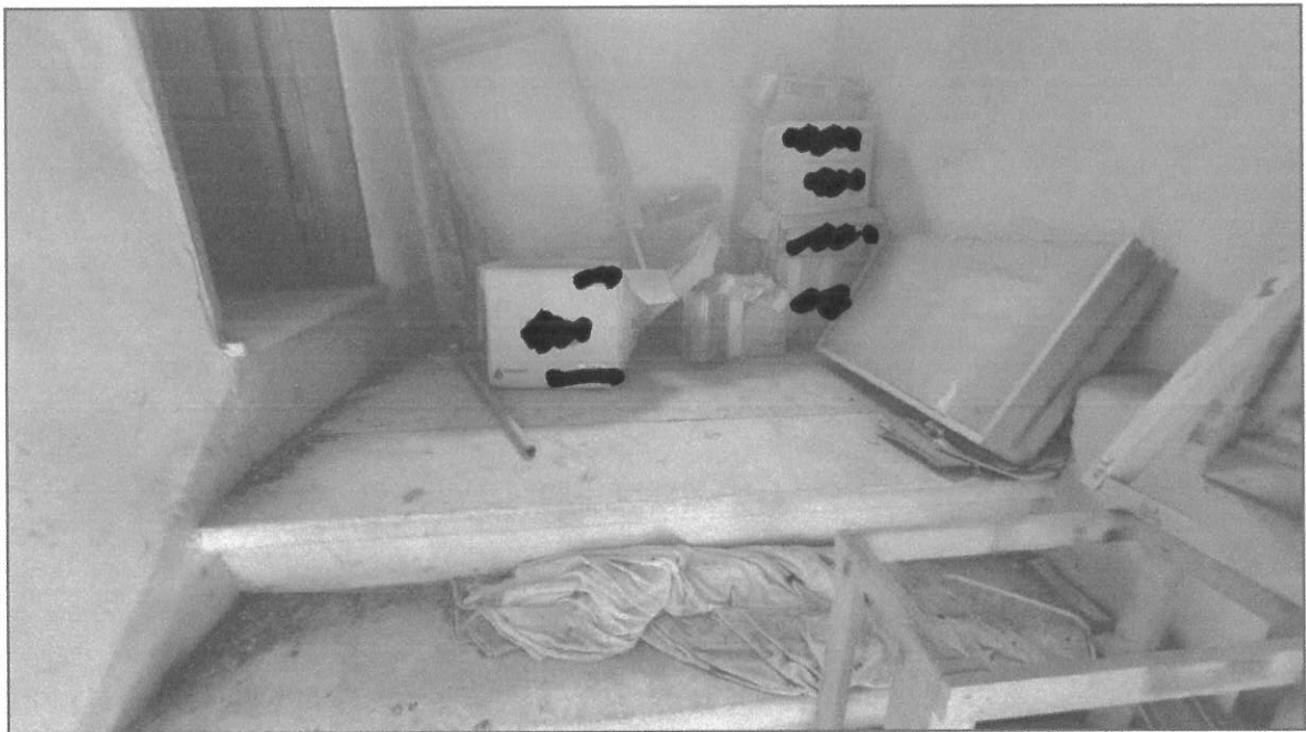
Foto 18: accesso al piano primo
