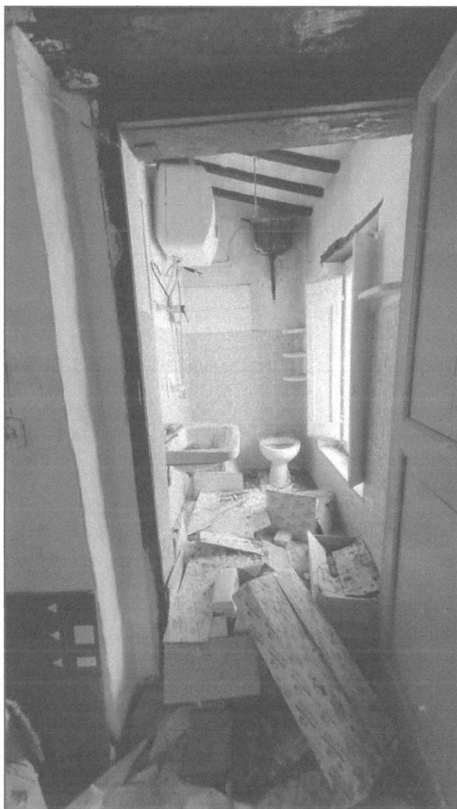
Foto 8: w.c. al piano secondo
