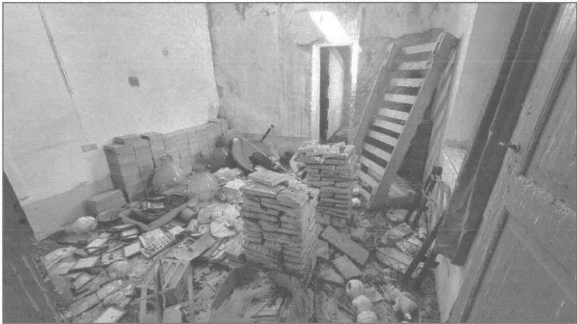
Foto 9 camera 2 al piano secondo
