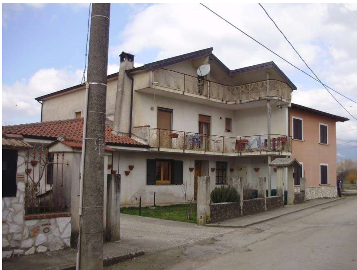
Foto n. 1 – fabbricato ad uso abitativo su via Ascolese
