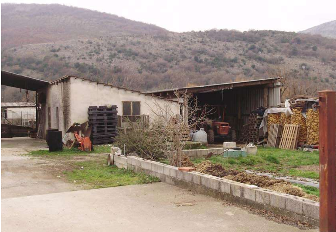
Foto n. 6 – fabbricato destinato a pollaio, porcilaia e forno e baracca in aderenza
