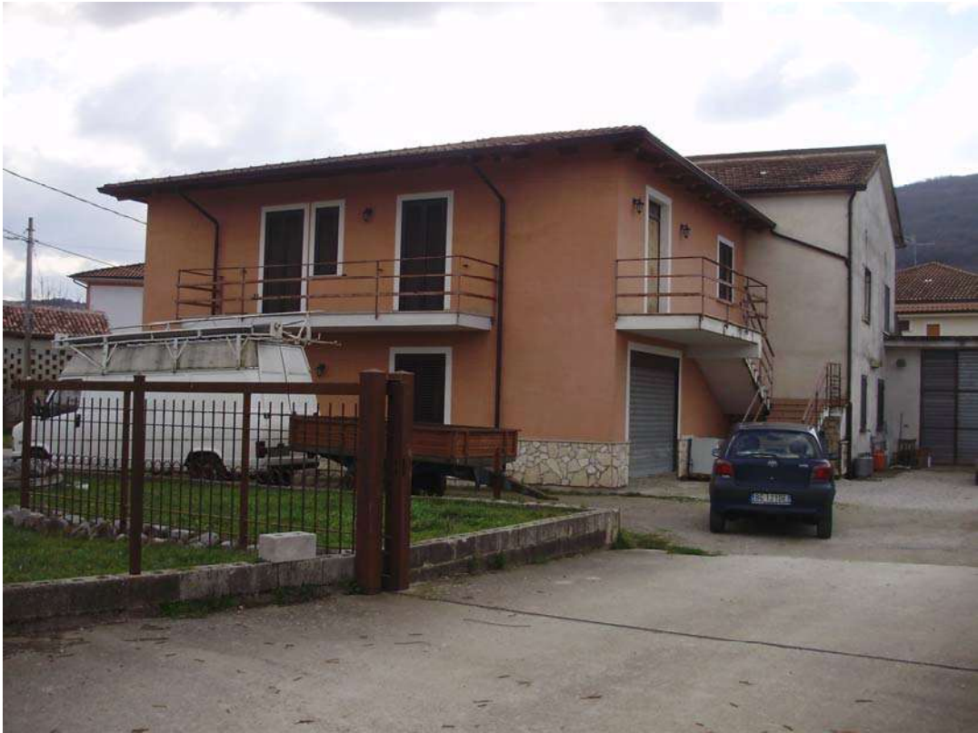
Foto n. 1 – fabbricato con corte
