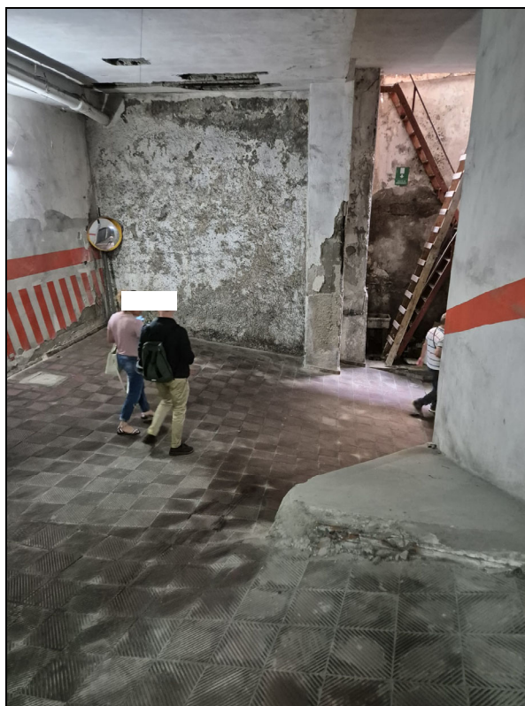
Foto 3 rampa di accesso al secondo piano sottostrada
