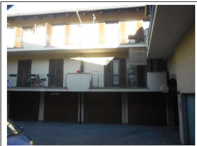
Facciata del corpo di fabbrica principale (manica interna) verso il cortile comune dove sono inseriti gli immobili in oggetto.
