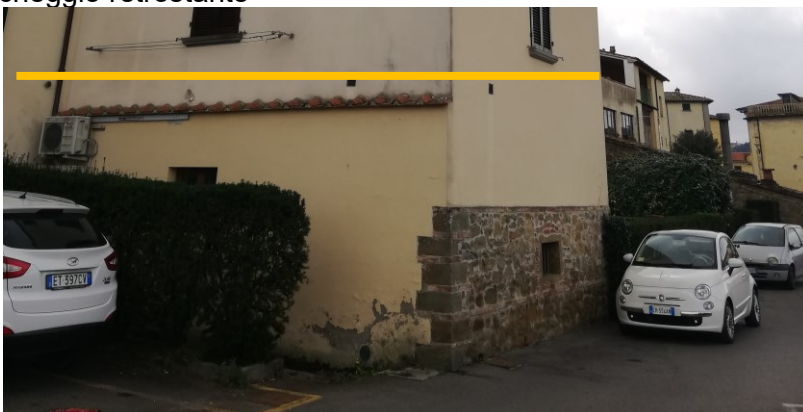
porzione della sola camera a p.Terra(n.119)
