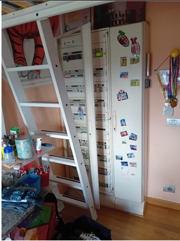
Quadro elettrico generale al piano terra
