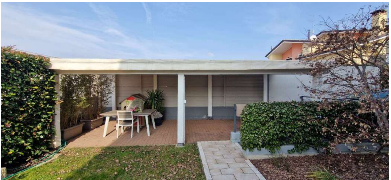
Manufatto da demolire
