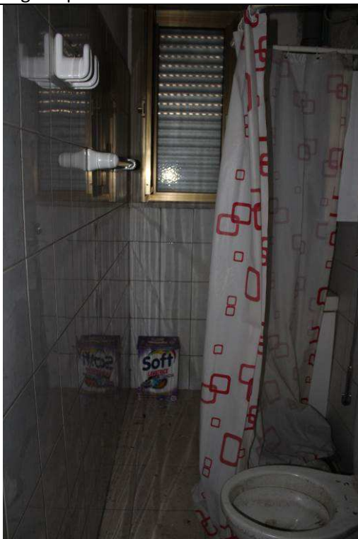
Bagno appartamento piano terra – fg. 21 part. 1713 sub 4
