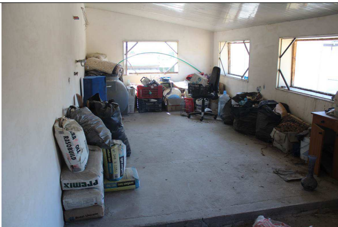
Mansarda abusiva al piano terzo
