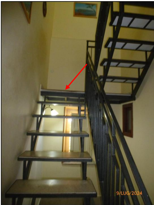
Foto 5 Scala collegamento al Piano 2°
