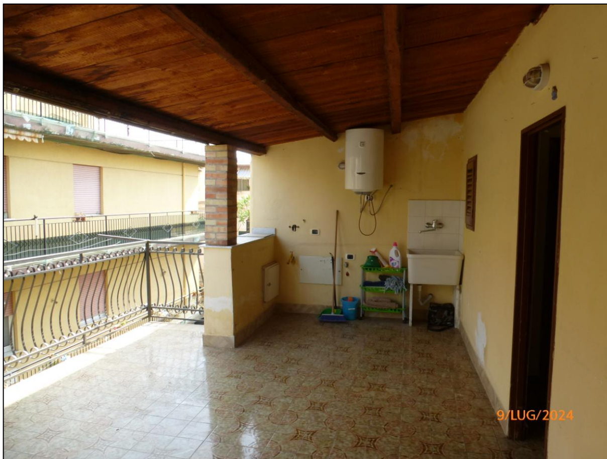
Foto 17 Balcone terrazzato - Piano 2° - (vista verso Ovest)
