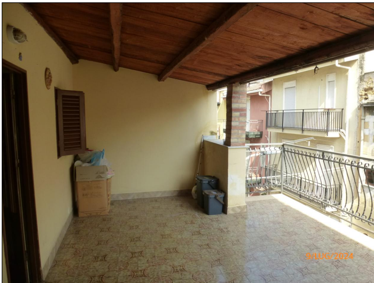
Foto 18 Balcone terrazzato - Piano 2° (vista verso Est).
