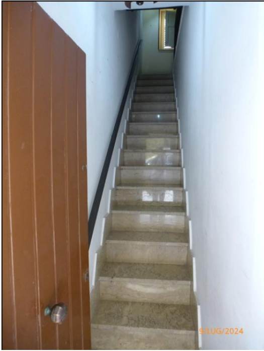
Foto 3 Ingresso da Via Restivo civ. 5
