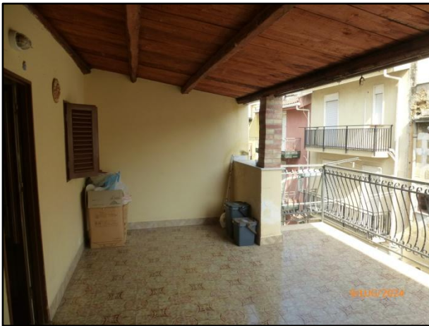
Balcone terrazzato - Piano 2°
