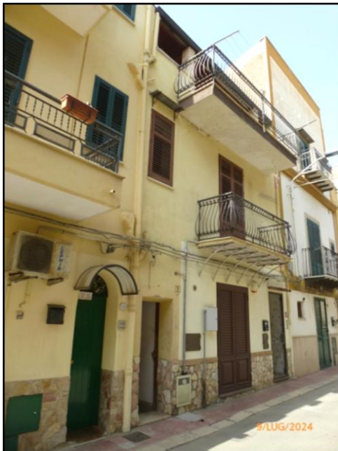
Prospetto principale su Via Restivo
