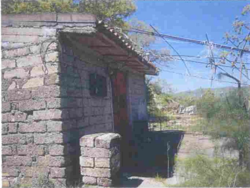
Figura 4. Vista prospetto centrale magazzino
