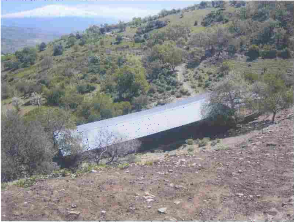
Figura 2. Vista panoramica fienile.
