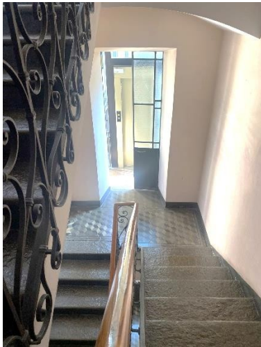
Vano scala e ascensore
