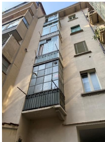
Veranda su cortile
