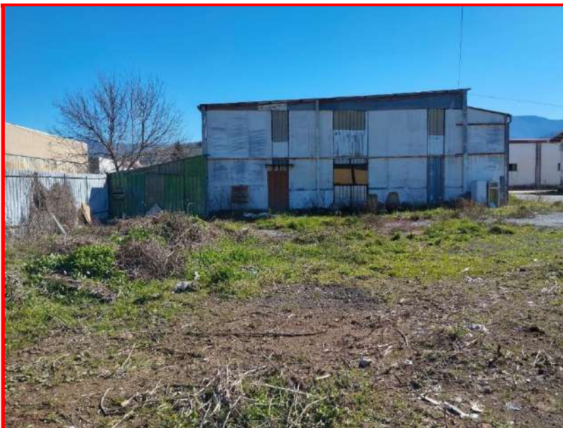
FOTO 3 – Vista angolo interno
