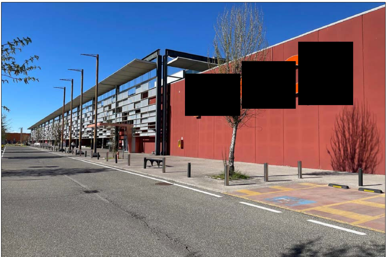
FOTO N. 2: Prospetto fabbricato "Centro commerciale Gotico" da parcheggio
