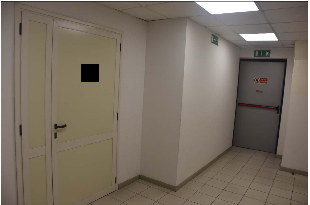
FOTO N. 12: Zona ingresso all'ufficio 695 sub. 39 -piano primo-
