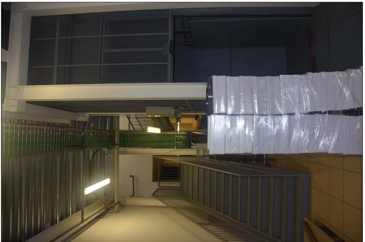
FOTO N. 8: Scala di accesso al soppalco
