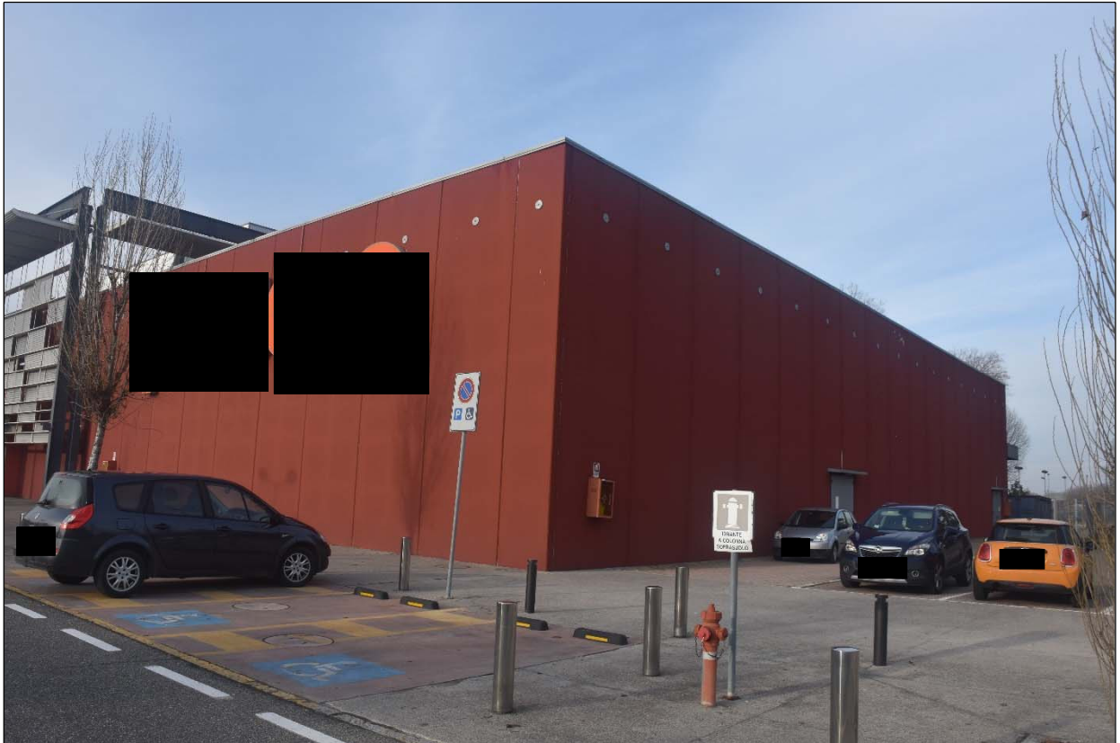
FOTO N. 1: Prospetto fabbricato "Centro commerciale Gotico" da parcheggio
