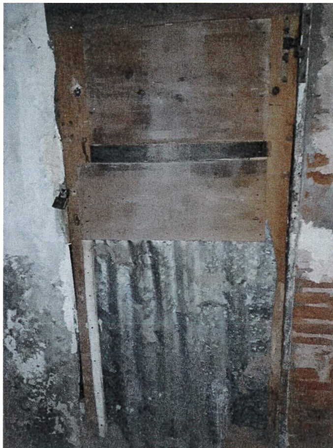
Foto n.7 – interno immobile/ripostiglio esterno p.sottostrada
