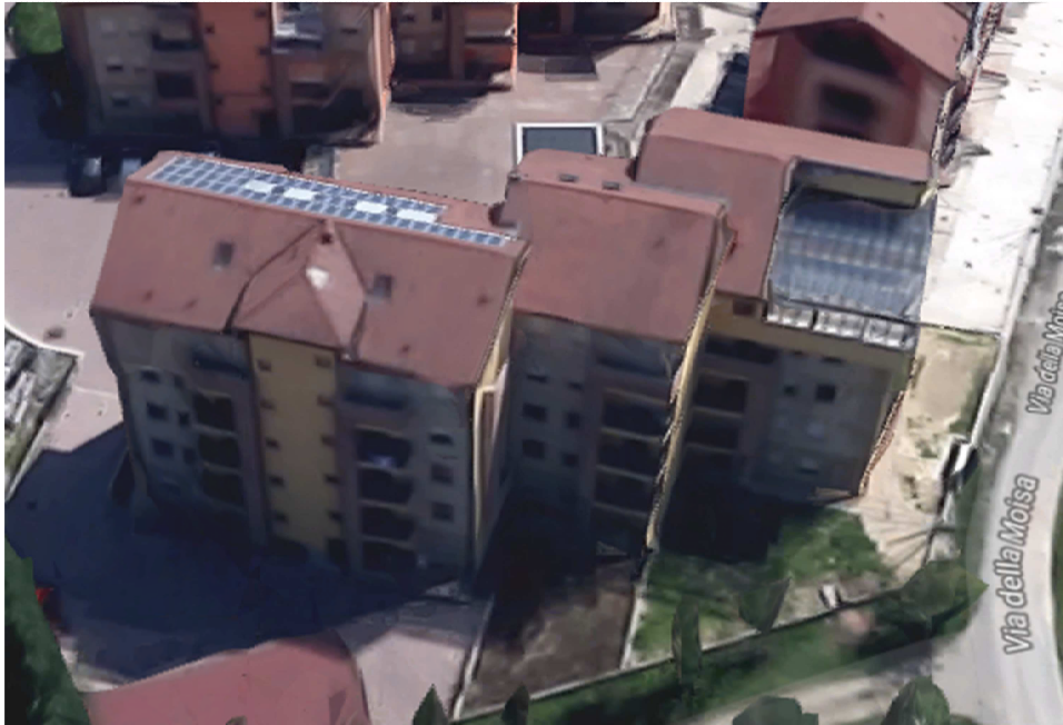
Vista aerea da est presa da Google
