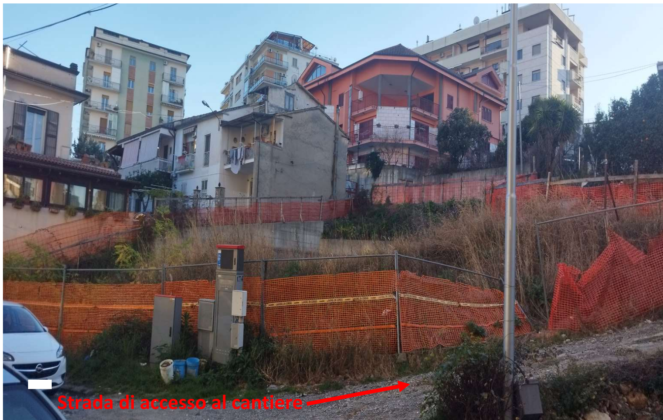
FOTO N°5: VISTA DELL'AREA DI CANTIERE DALLA PROSPICENTE VIA DE RADA; P.LLA 413.
