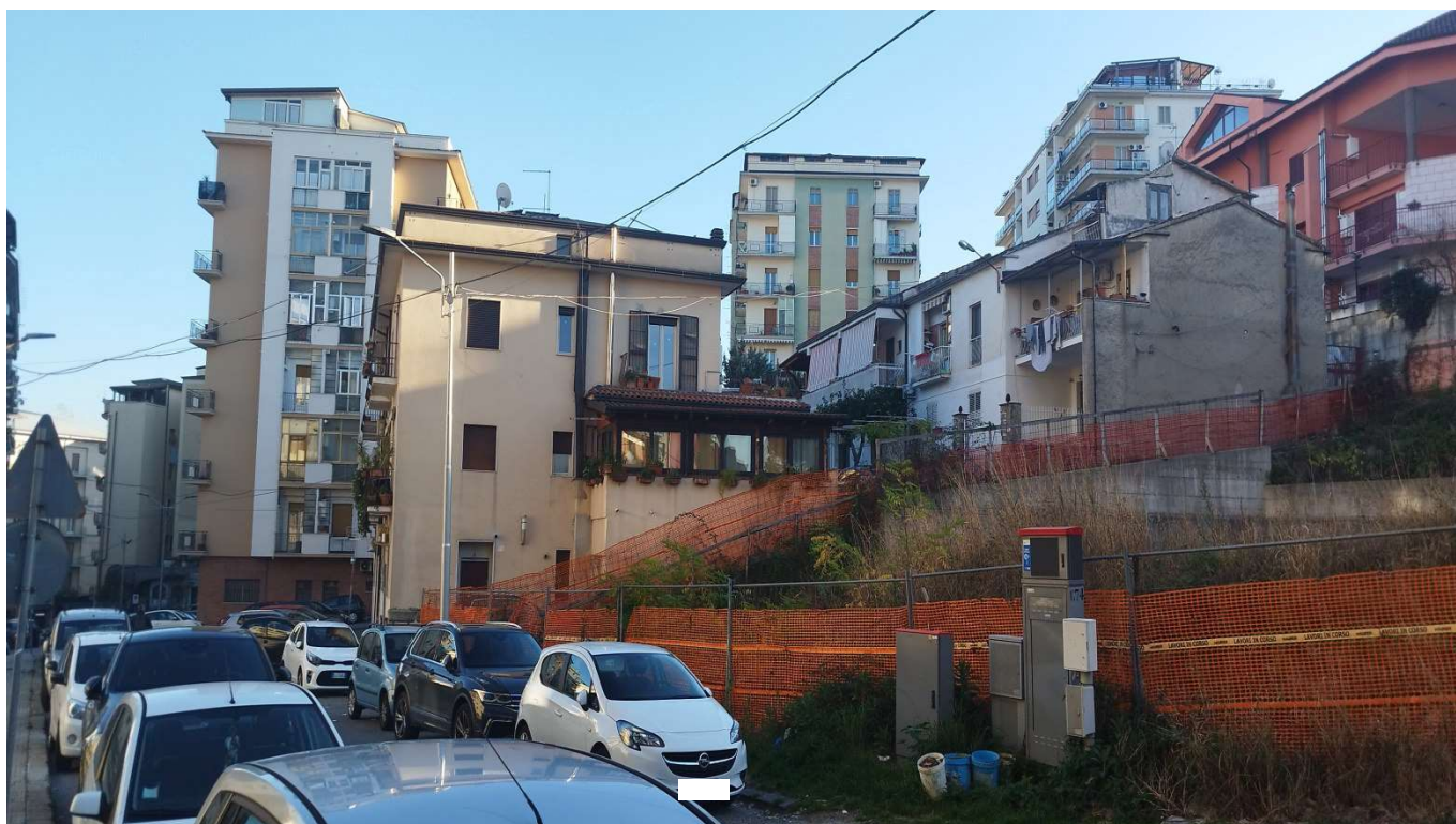
FOTO N°6: VISTA DELLA RECINZIONE DELL'AREA OGGETTO DI ESECUZIONE (OGGI CANTIERE EDILE SUL CONFINE PROSPICENTE VIA DE RADA (SUD-EST));
