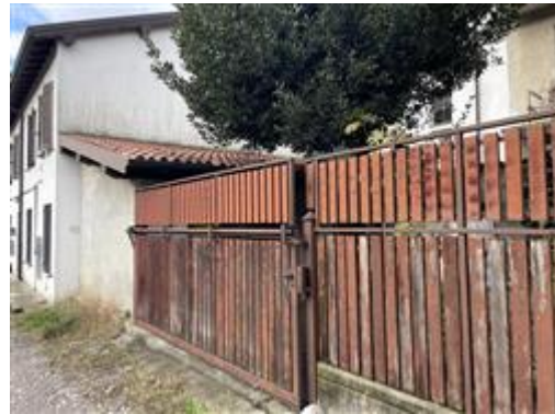
recinzione dell'area pertinenziale
