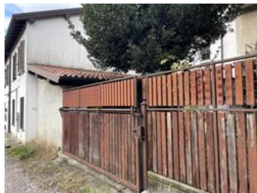
recinzione dell'area pertinenziale
