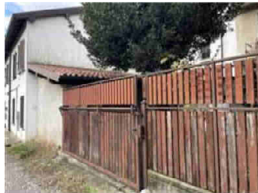
recinzione dell'area pertinenziale
