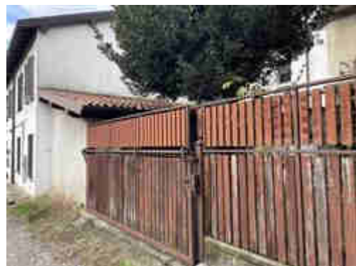
recinzione dell'area pertinenziale
