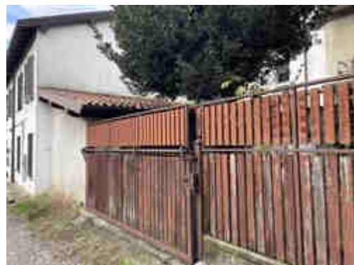
recinzione dell'area pertinenziale
