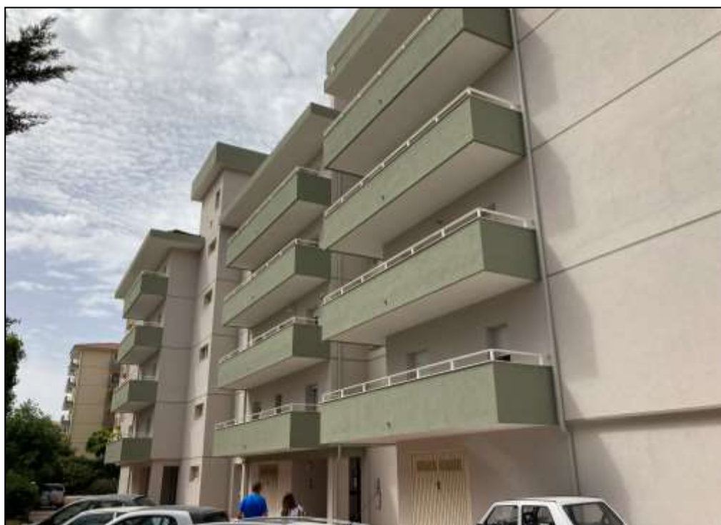
Foto n. 2 – Prospetto Est (con ingresso dell'edificio)
