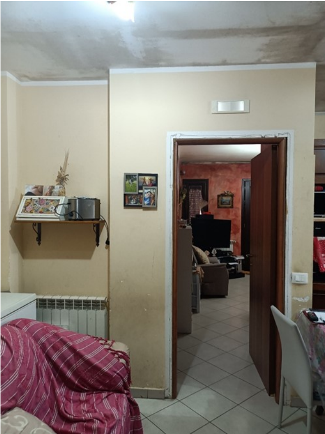
Foto n° 18 (porta interna cucina con coprifili mancanti)
