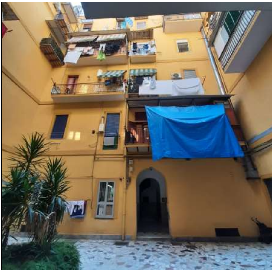
Accesso alla Scala B
