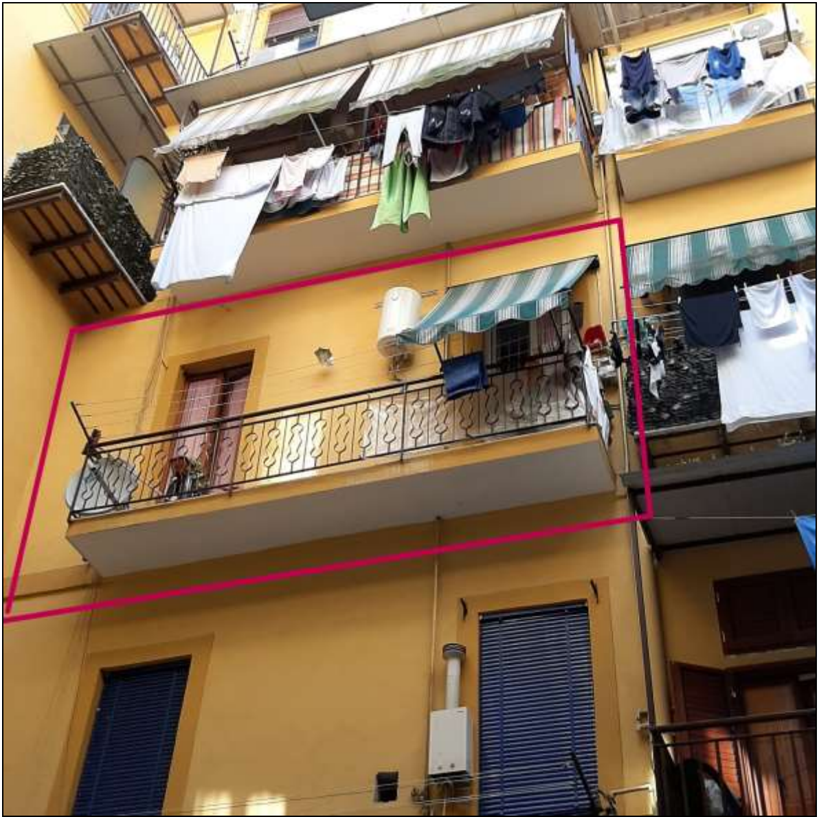
Immobile evidenziato VIC _ fl. 10_ p.la 402 _ sub 58
