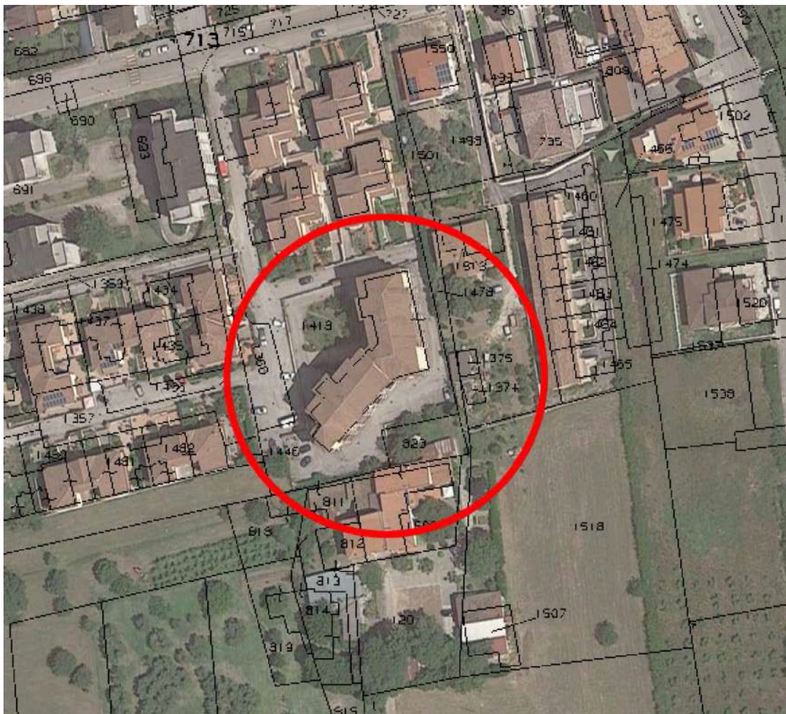
Imm.n.10: sovrapposizione tra la foto aerea da google maps e foglio di mappa catastale in registro del Catasto Fabbricati al Foglio n.9 – particella n.1418 al fine di individuare il fabbricato condominiale alla Via degli Aironi n.11 in Telese Terme (Bn.) ex Via Fausto Coppi s.n.c..
