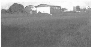
FOTO 8: capannone su part. 943 LOTTO 3
