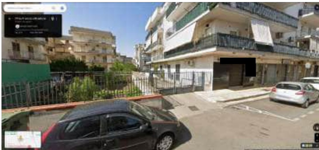
Figura 49 - Vista esterna dell' accesso alla rampa di discesa ai box.
