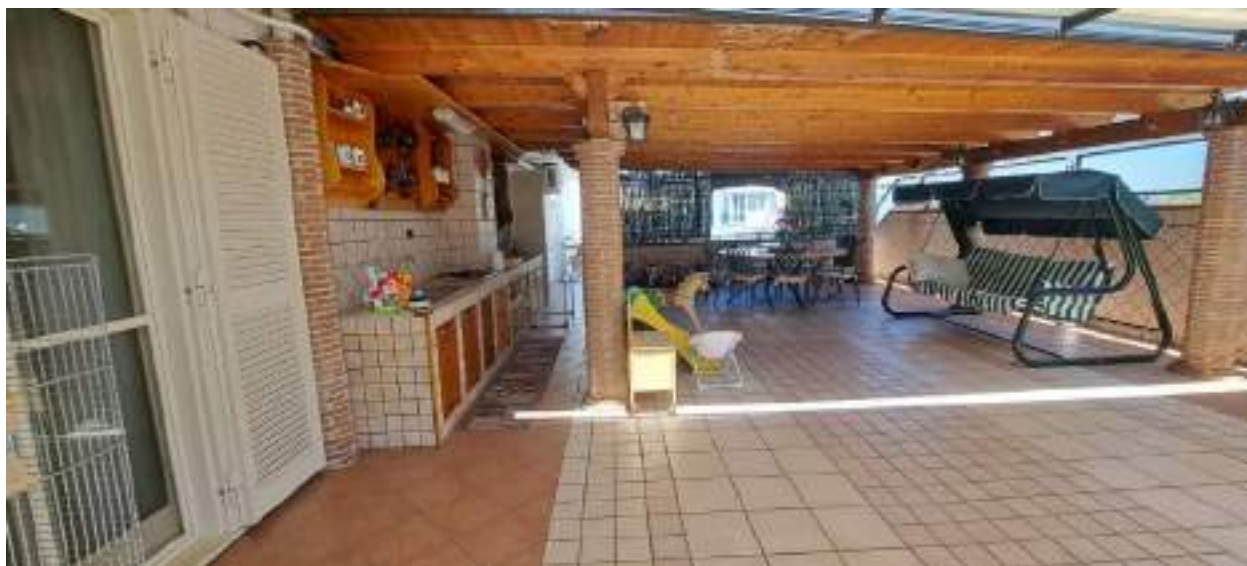
Figura 16 - Tettoia in legno su terrazza
