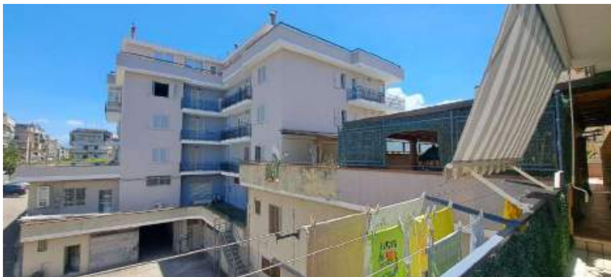
Figura 19 - Balcone - Lato EST
