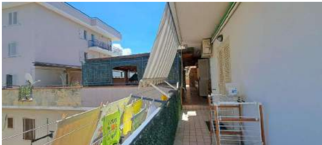
Figura 18 - Balcone - Lato EST
