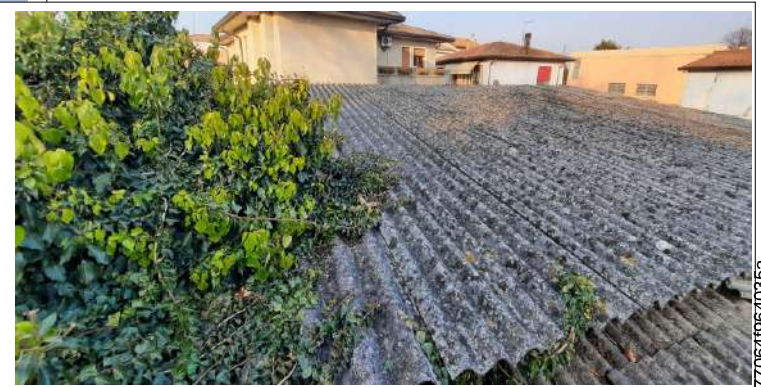
Copertura autorimessa in cemento amianto
