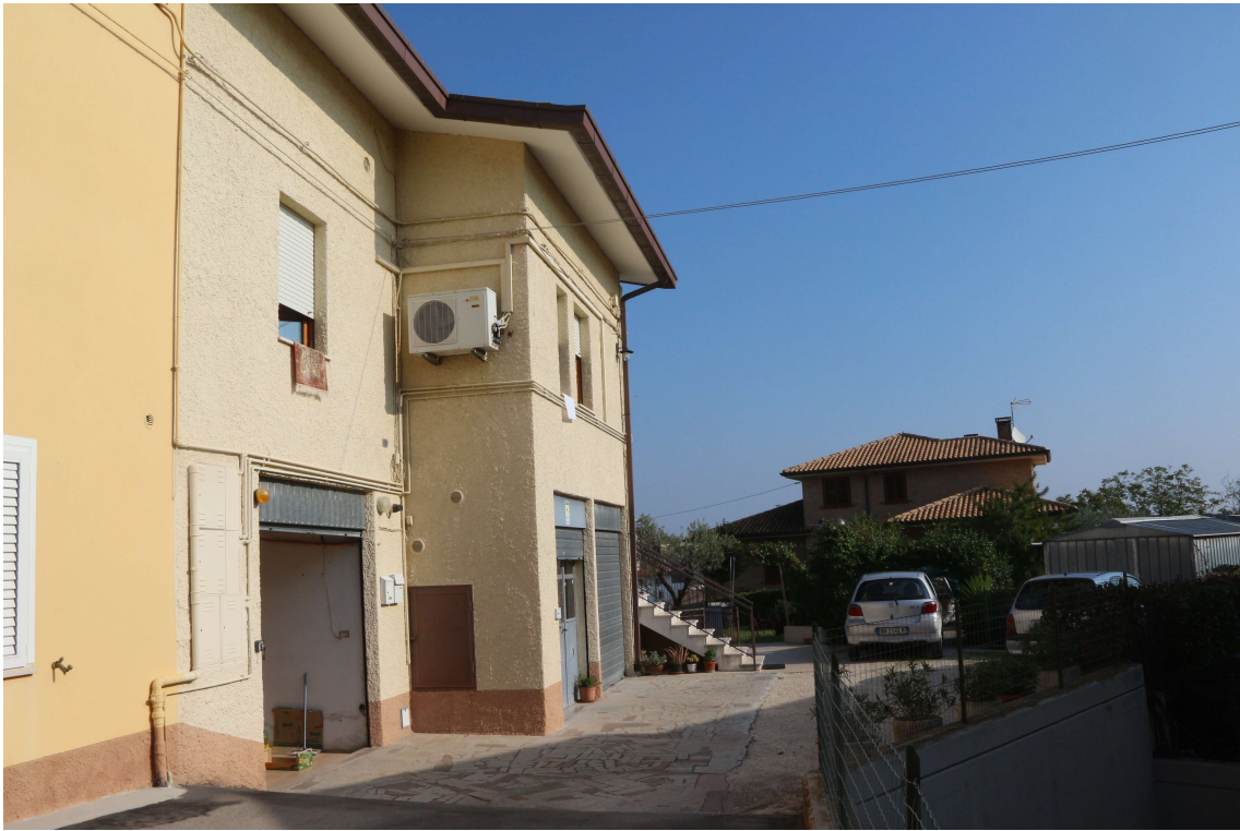
FOTO 3 – VISTA VERSO INGRESSO GARAGE E UNITA' ABITATIVA
