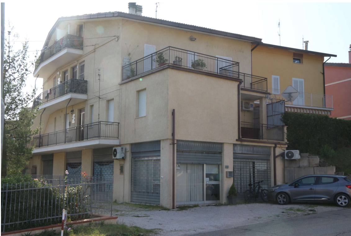
FOTO 7 – VISTA TOTALE FABBRICATO DA NORD - OVEST
