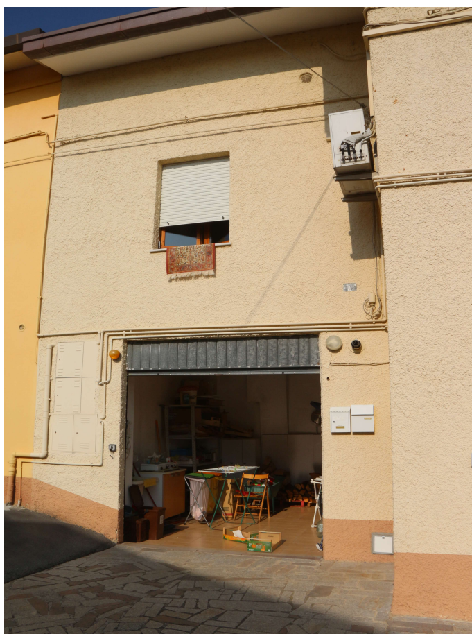
FOTO 8 – VISTA INGRESSO GARAGE LATO EST
