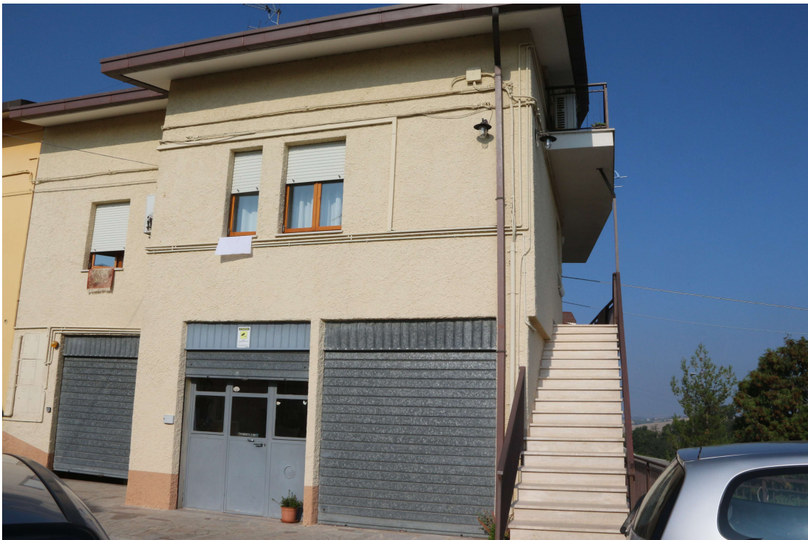
FOTO 4 – VISTA DA EST VERSO SCALA DI ACCESSO ALL'UNITA' ABITATIVA
