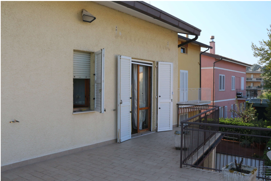
FOTO 12 – VISTA ESTERNA VERSO SUD PARETE LATO OVEST 1° PIANO
