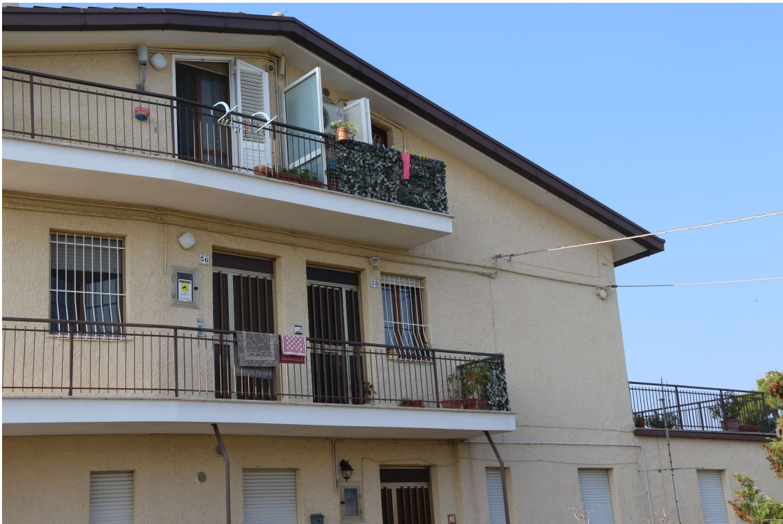
FOTO 5 – VISTA PARZIALE LATO NORD VERSO PIANO 1° E 2°
