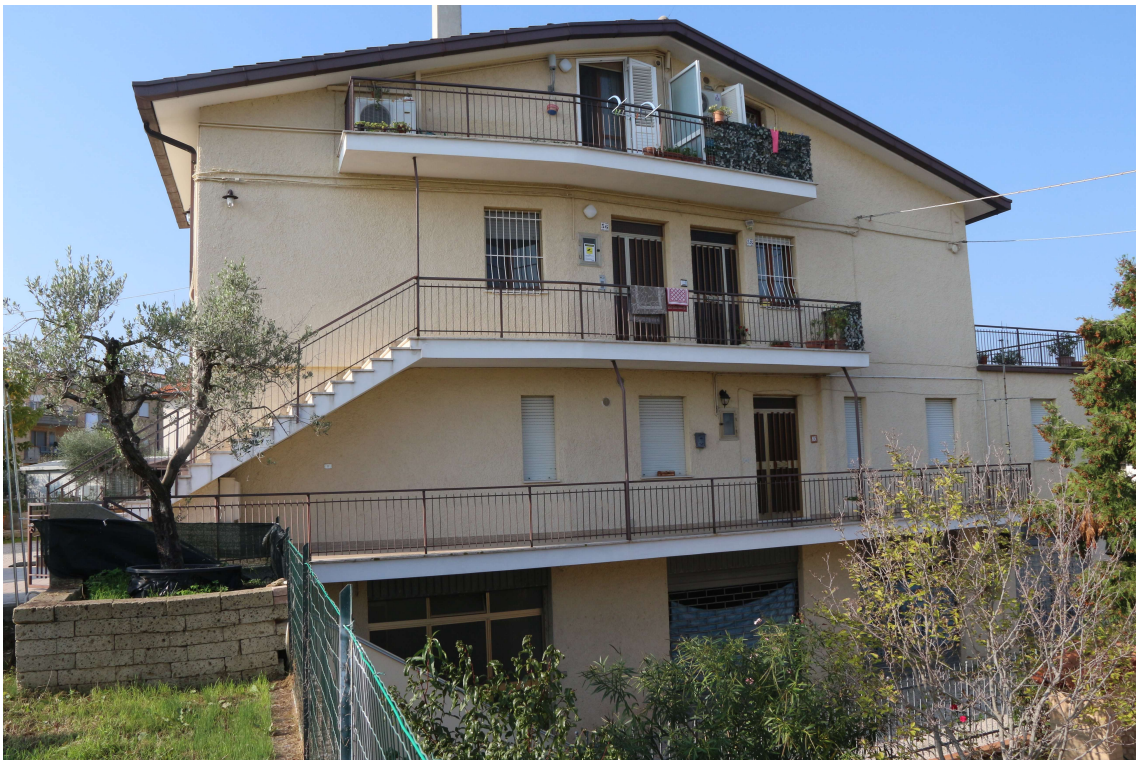
FOTO 6 – VISTA TOTALE LATO NORD INTERO FABBRICATO
