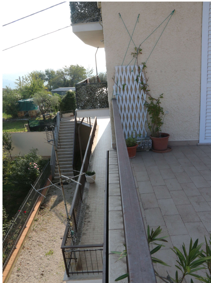
FOTO 10 – VISTA ESTERNA PARZIALE PARETE LATO OVEST
