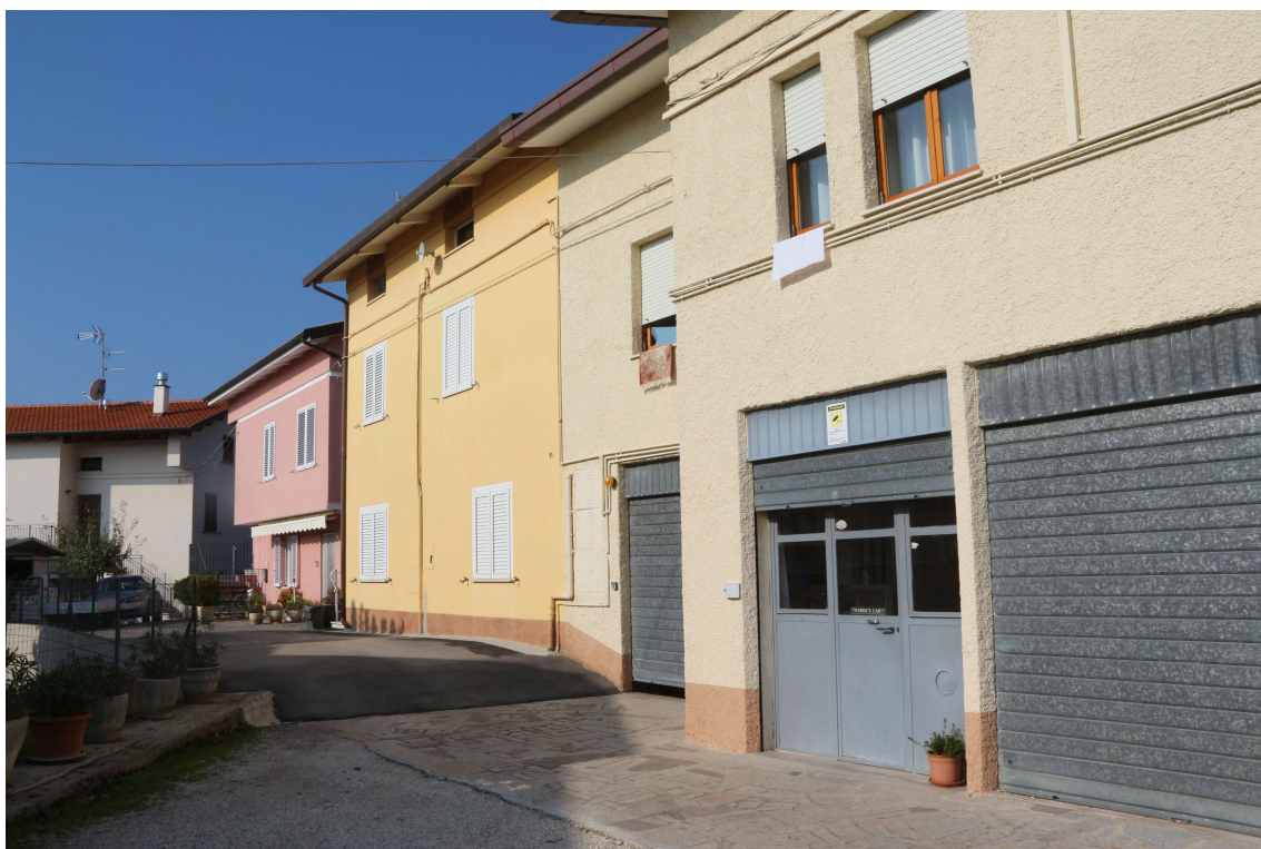
FOTO 2 – VISTA PARZIALE FABBRICATO DA NORD (verso strada di accesso al lotto)
