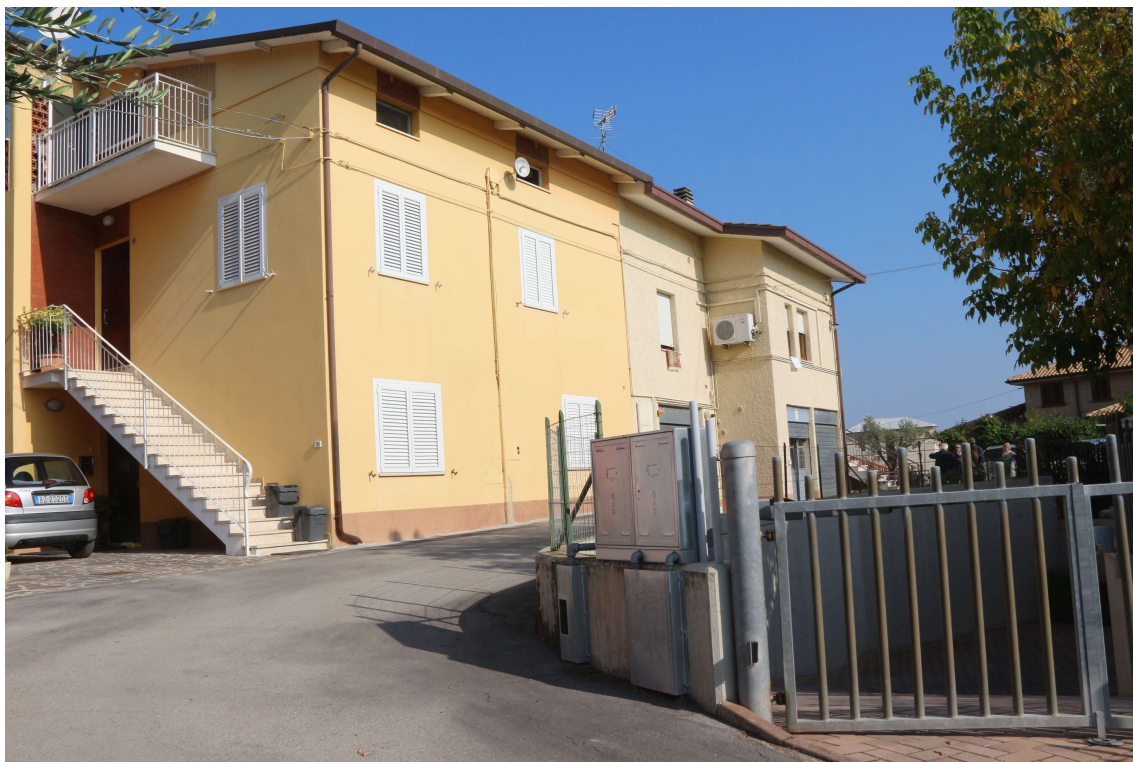
FOTO 1 – VISTA FABBRICATO DA SUD (dalla strada di accesso al lotto)
