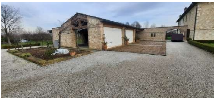
E): Fabbricato esterno oggetto di ordinanza di demolizione
