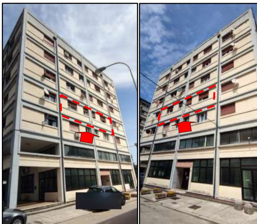
Figura 4-5. Vista condominio da sud (due angolazioni) appartamento al 3° piano oggetto di pignoramento
