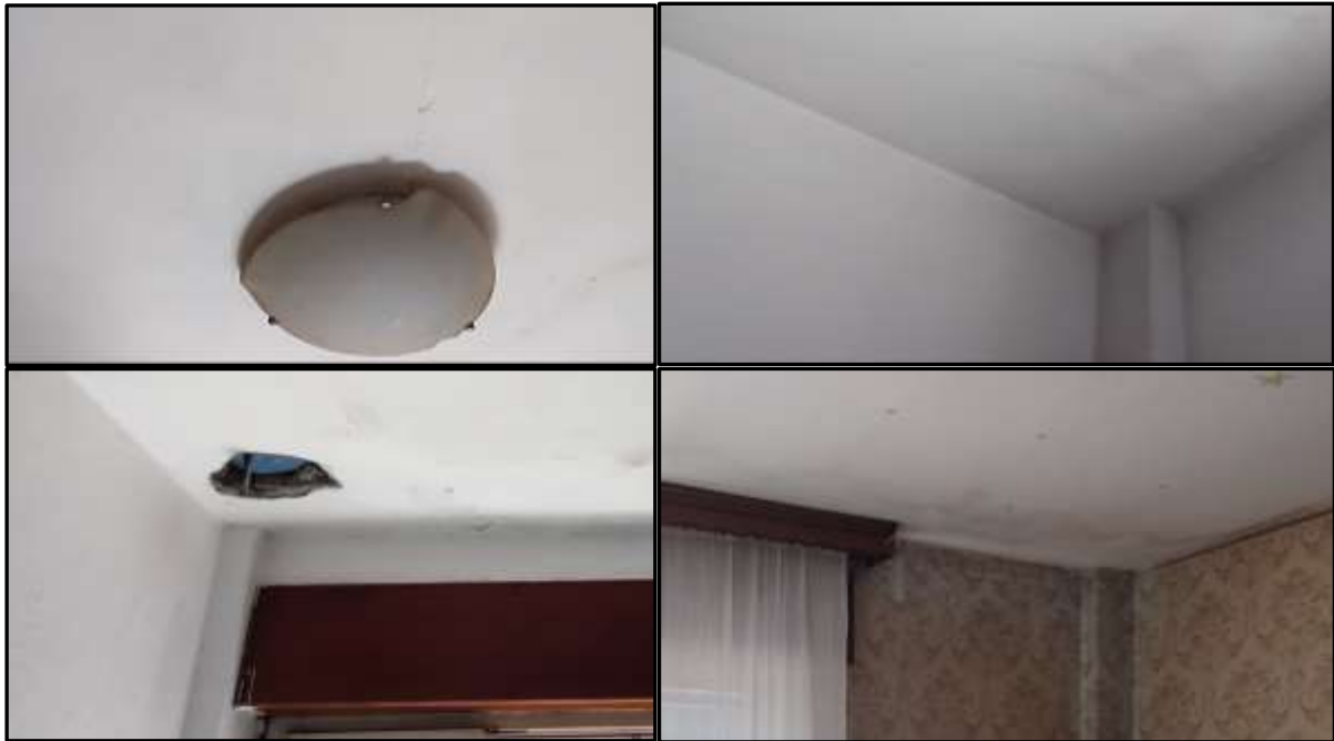
Figura 21-22-23-24. Crepe e macchie di umidità – foro dal 4° piano sul soffitto del bagno
