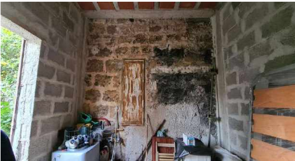
Magazzino/locale deposito - interno
