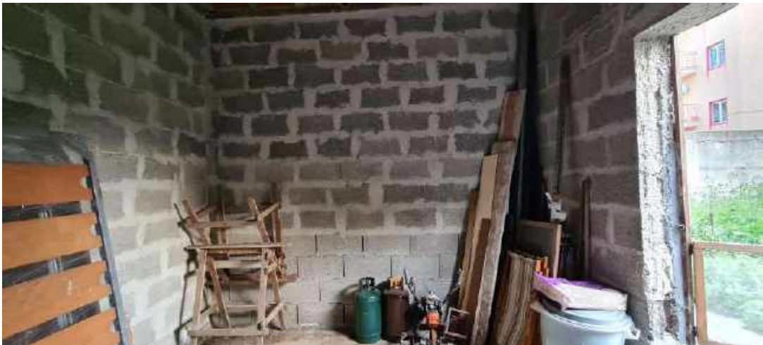
Magazzino/locale deposito – interno
