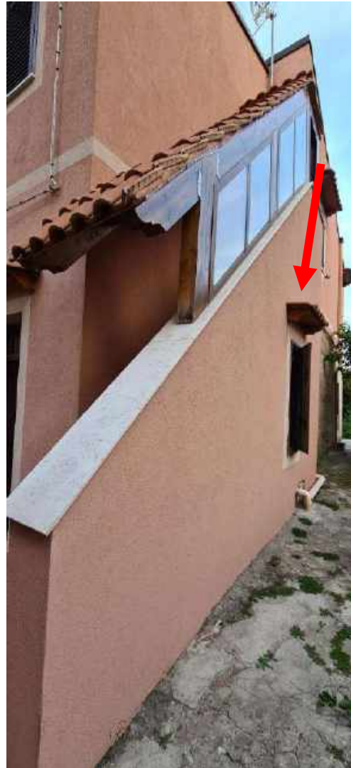
Infisso servizio igienico (sottoscala)
