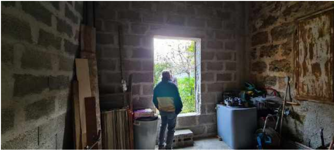
Magazzino/locale deposito – interno
