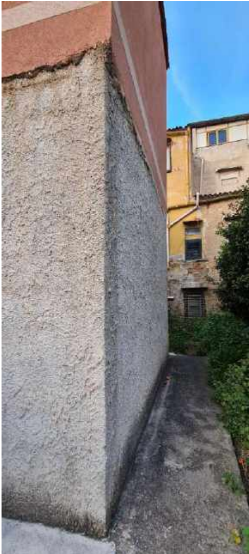
Magazzino/locale deposito- Retrospetto
