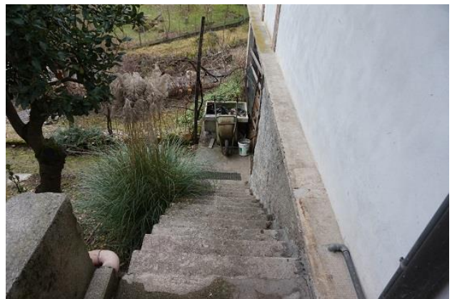
Scala esterna ad est da nord
