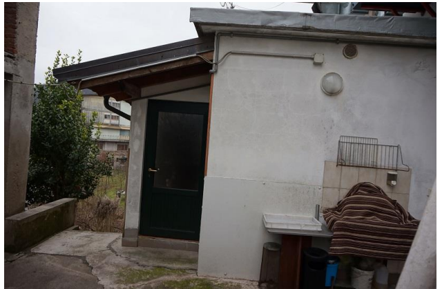
Fronte nord da area esterna ad est
