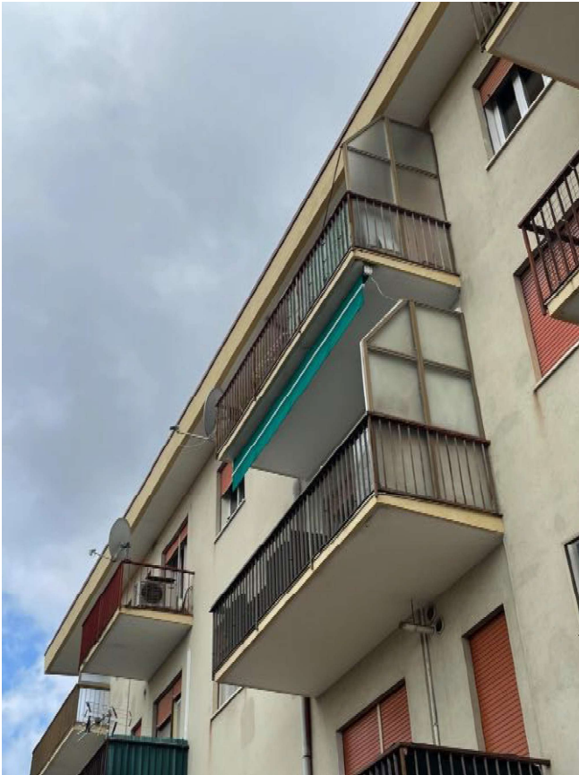
Dettaglio prospetto Sud-Est dell'edificio (appartamento al terzo piano)
