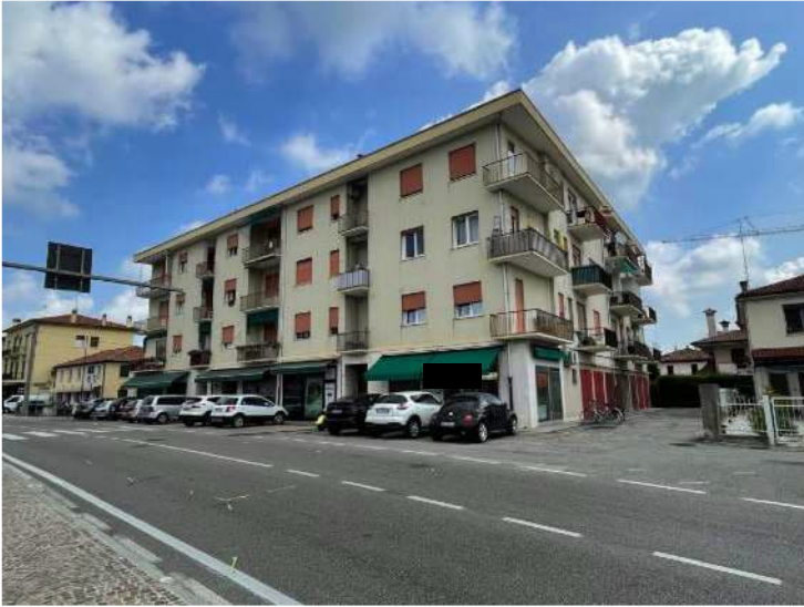
Prospetti Sud-Est e Sud-Ovest dell'edificio (appartamento al terzo piano)
