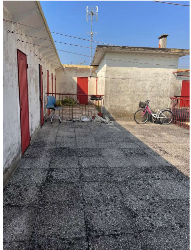
Terrazzo comune (quarto piano sottotetto)
