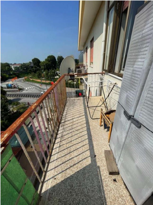
Balcone (terzo piano)
