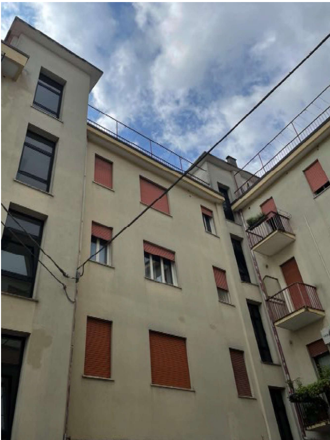
Dettaglio prospetto Nord-Est dell'edificio (appartamento al terzo piano)
