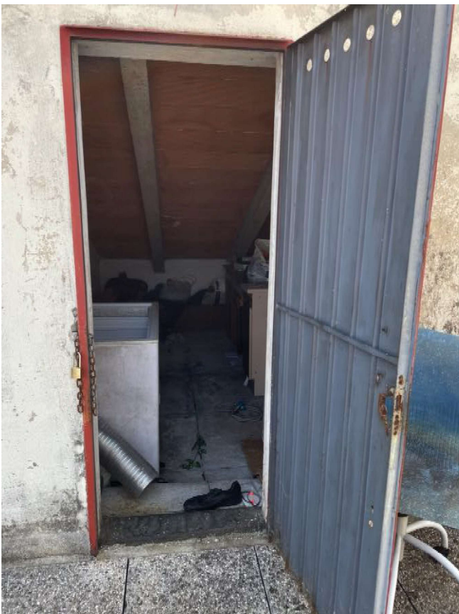
Magazzino (quarto piano sottotetto)
