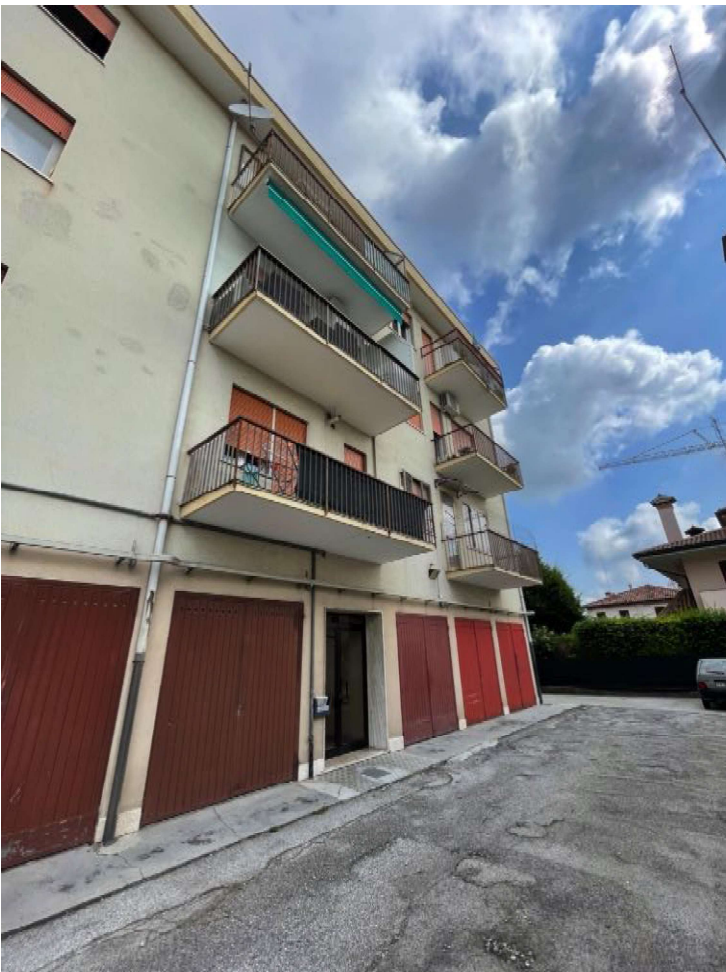
Prospetto Sud-Est dell'edificio (appartamento al terzo piano)
