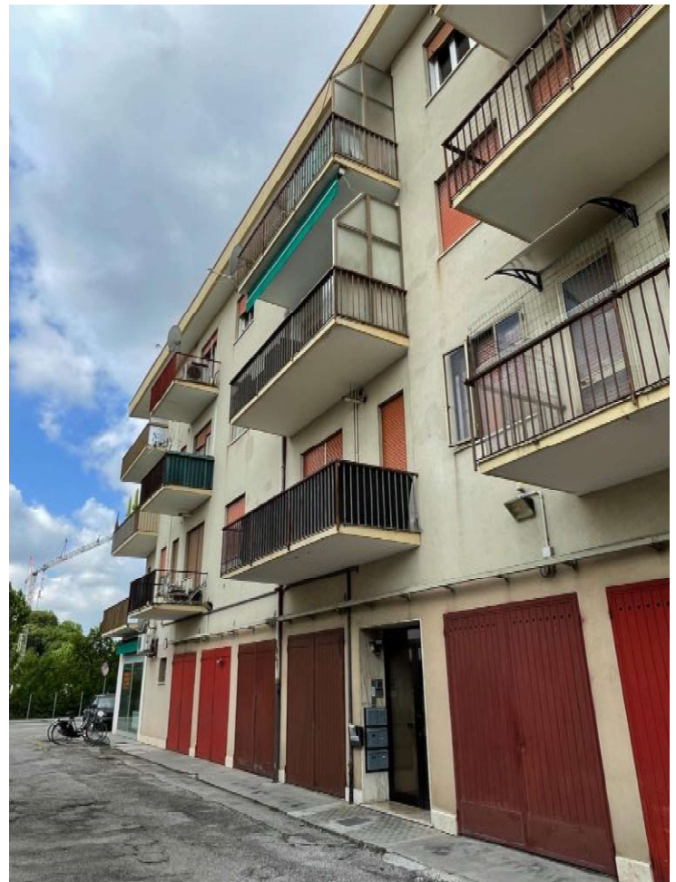
Prospetto Sud-Est dell'edificio (appartamento al terzo piano)
