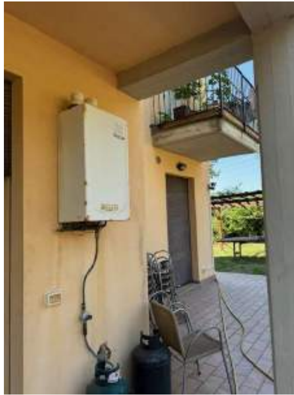
Foto 11 – caldaia
