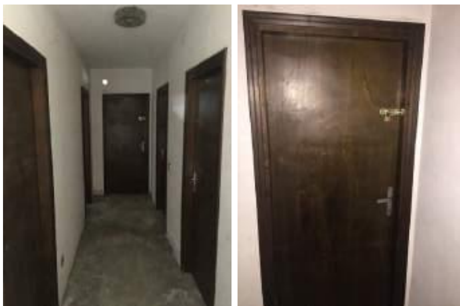
Fotografie 9 a, b – corridoio piano interrato, porta cantina (non accessibile)
