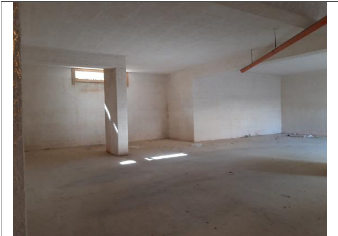
Foto 03 – Vista della porzione del piano cantinato antistante il cancello di ingresso.-
