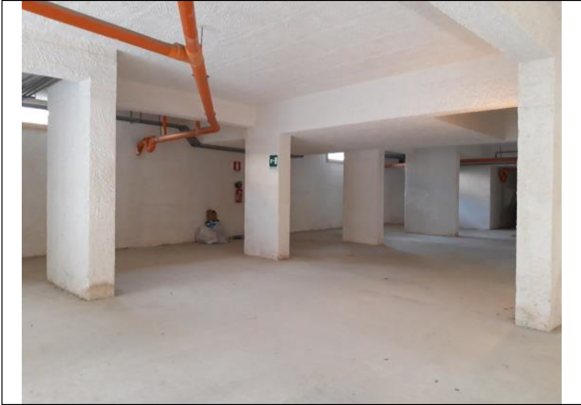
Foto 02 – Vista della porzione del piano cantinato antistante l’accesso pedonale dal vano scala (comprendente il posto auto sub 15 – penultimo dalla dx della foto – in corrispondenza della luce).-
