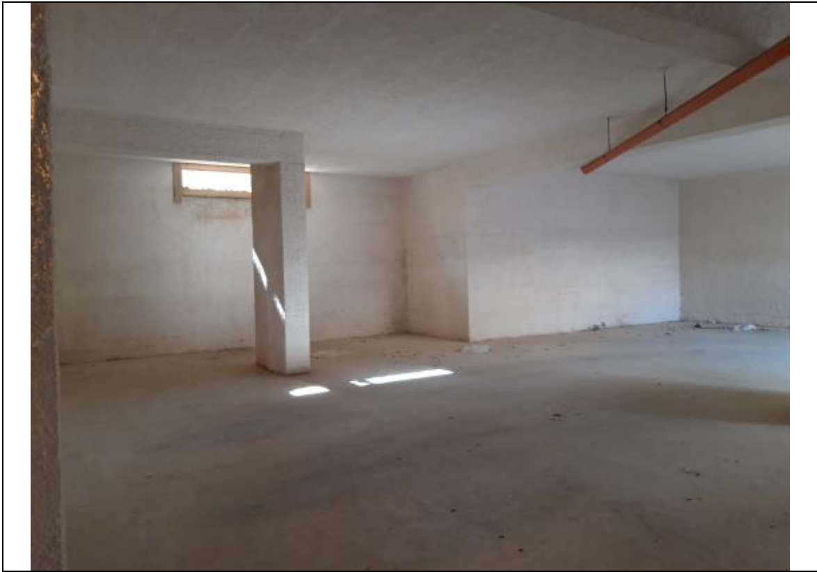
Foto 02 – Vista della porzione del piano cantinato antistante il cancello di ingresso (comprendente il posto auto sub 22 - a dx all'interno della risega).-
