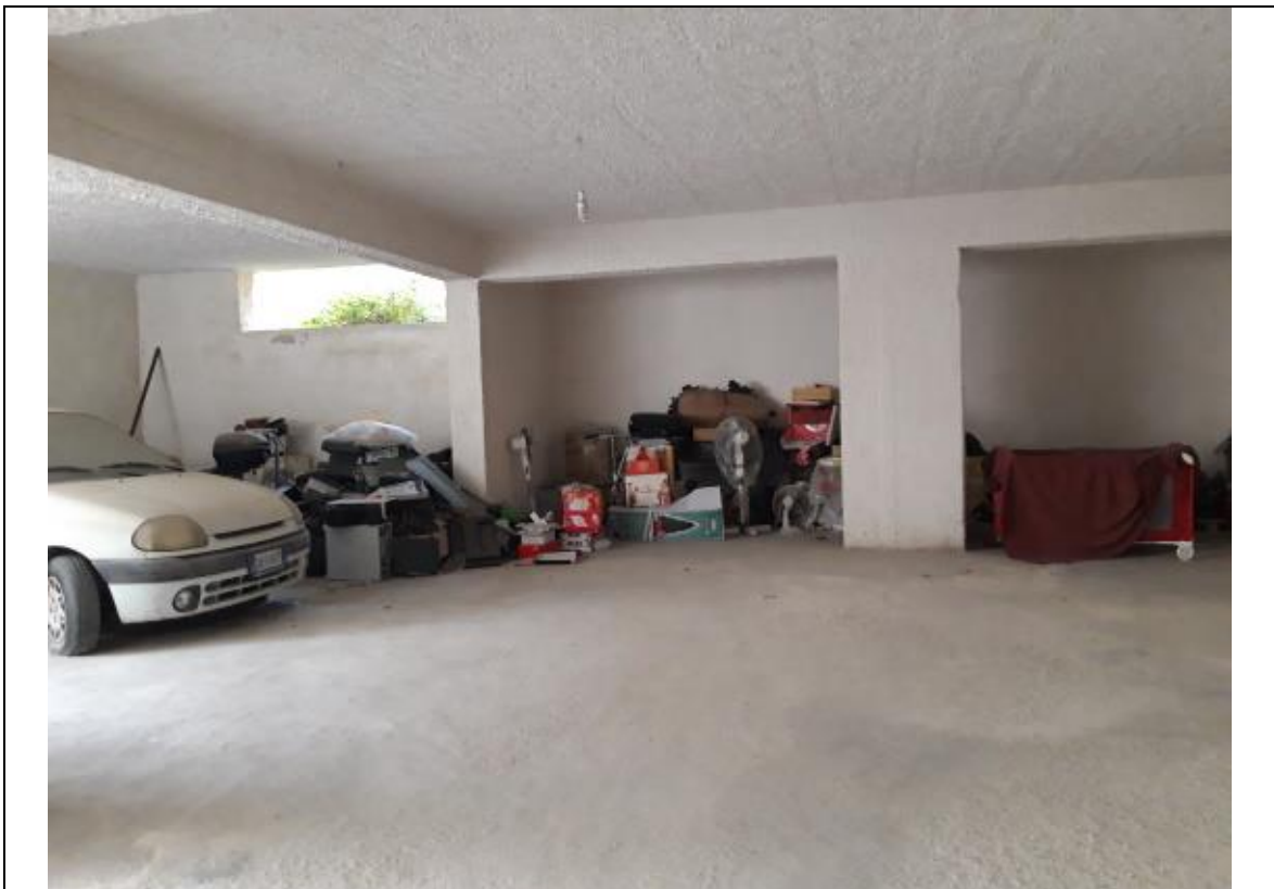
Foto 03 – Vista della porzione del piano cantinato a destra del cancello di ingresso.-
