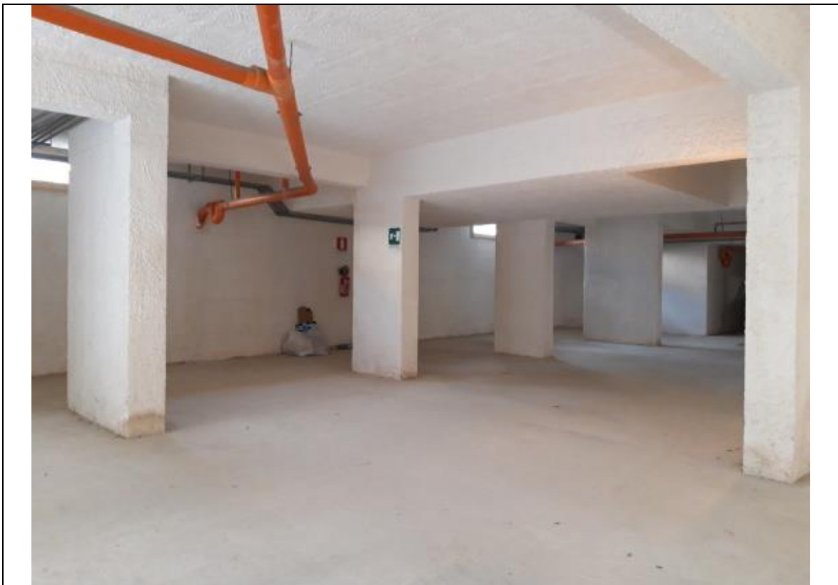
Foto 03 – Vista della porzione del piano cantinato antistante l'accesso pedonale dal vano scala.-
