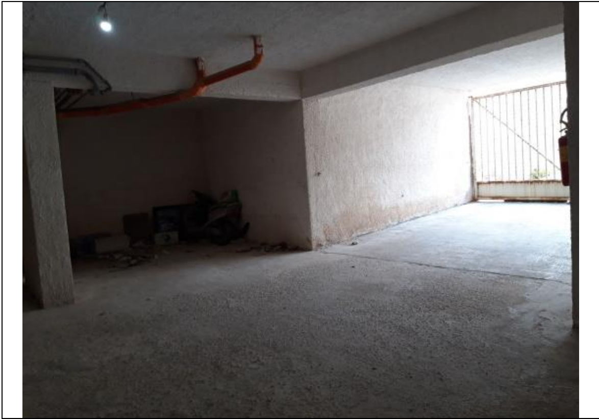
Foto 02 – Vista della porzione del piano cantinato a sinistra del cancello di ingresso.-
