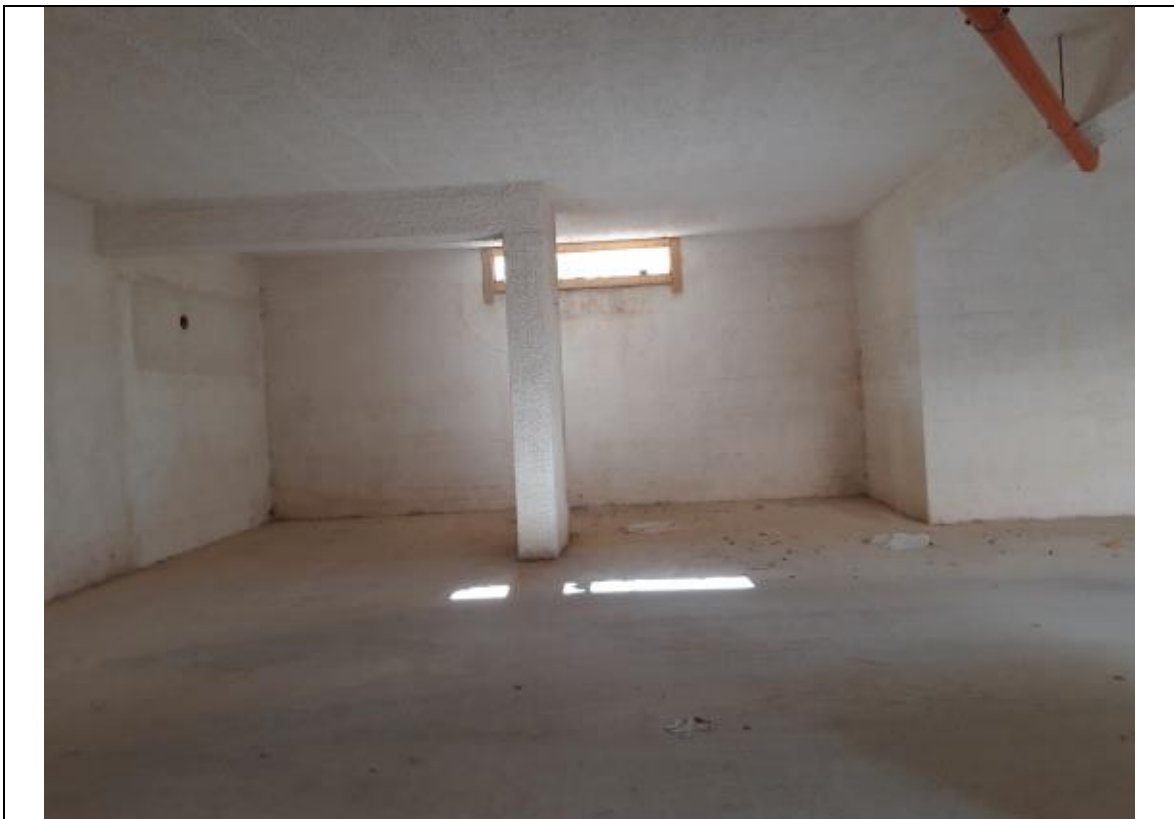
Foto 01 – Vista posto auto sub 22 (a dx all'interno della risega).-
