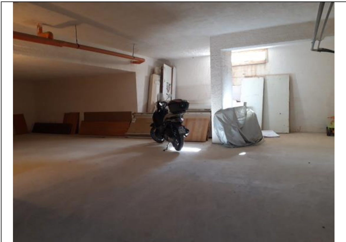
Foto 05 – Vista della porzione del piano cantinato non antistante al cancello di ingresso.-
