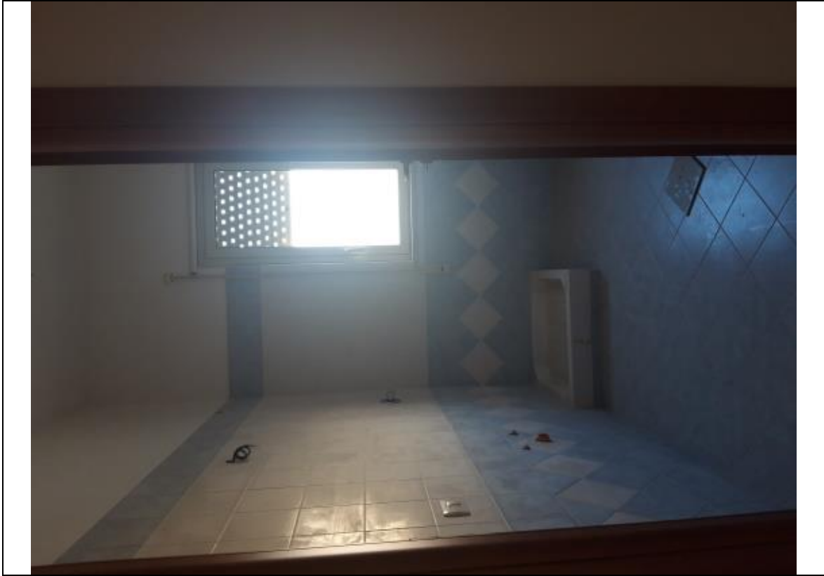
Foto 11 – Vista interna – vano wc.-
