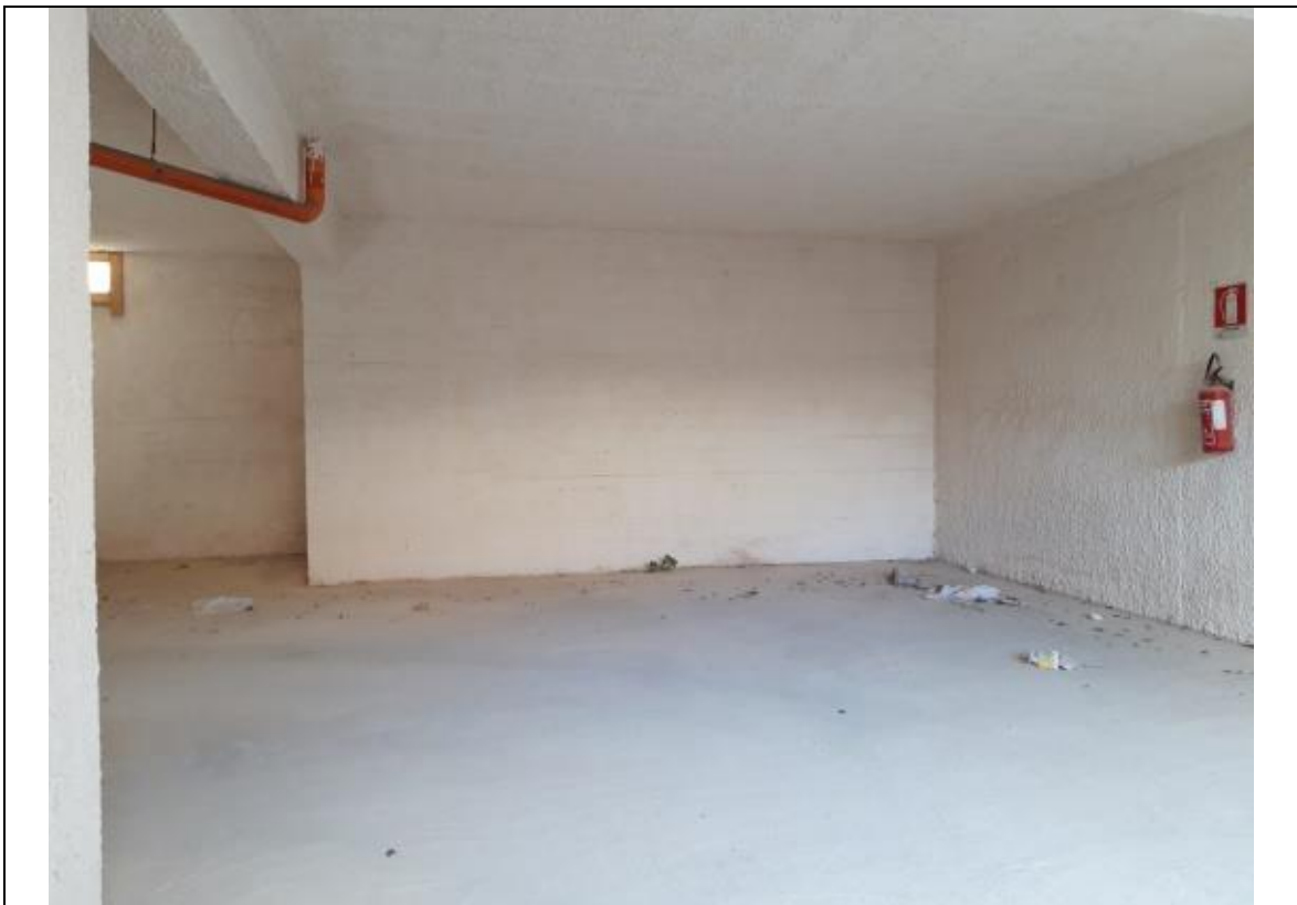
Foto 01 – Vista posto auto sub 23 (il primo a sx dopo la risega).-
