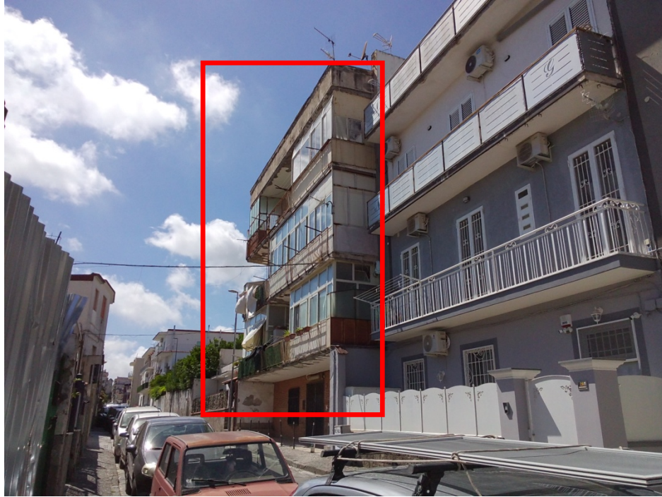
FOTO 1 fabbricato visto da via Giacomo Matteotti
