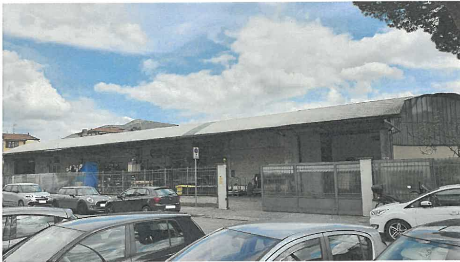
Ingresso via Fiora n.c. 4 e 4/a
