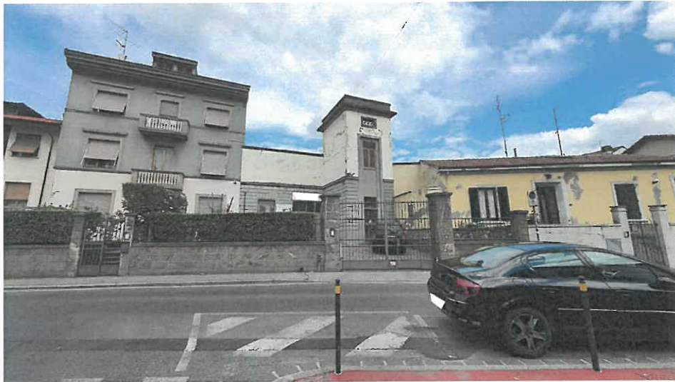
Ingresso via Montalese n.c. 152
