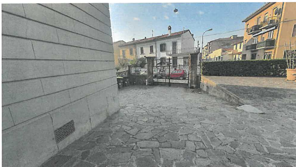
Piazzale lato via Montalese n.c. 152
