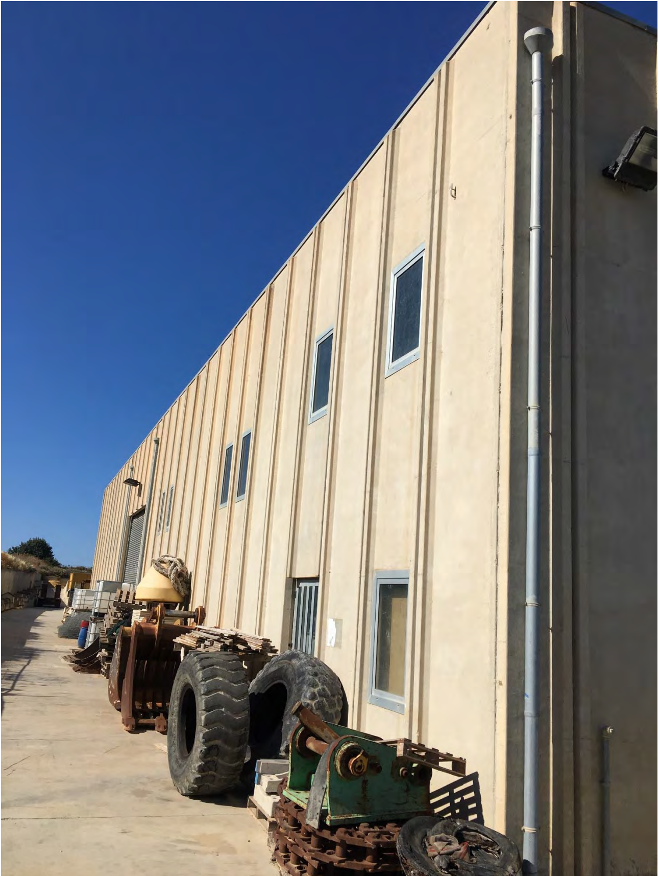
Lotto 6 Capannone Artigianale – Zona Artigianale Scicli
