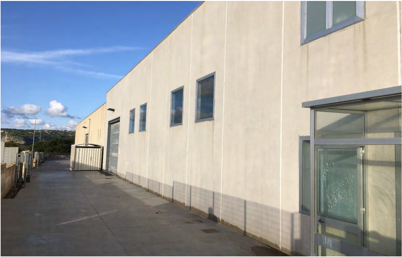
Lotto 7 Capannone Artigianale – Zona Artigianale Scicli
