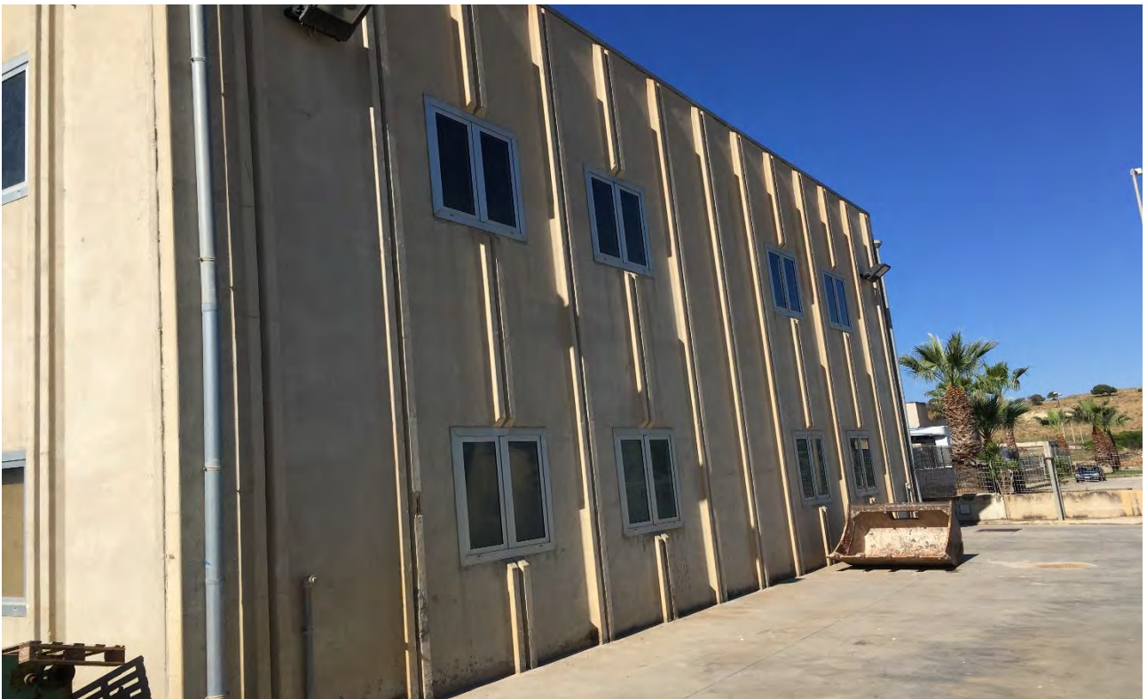
Lotto 6 Capannone Artigianale – Zona Artigianale Scicli
