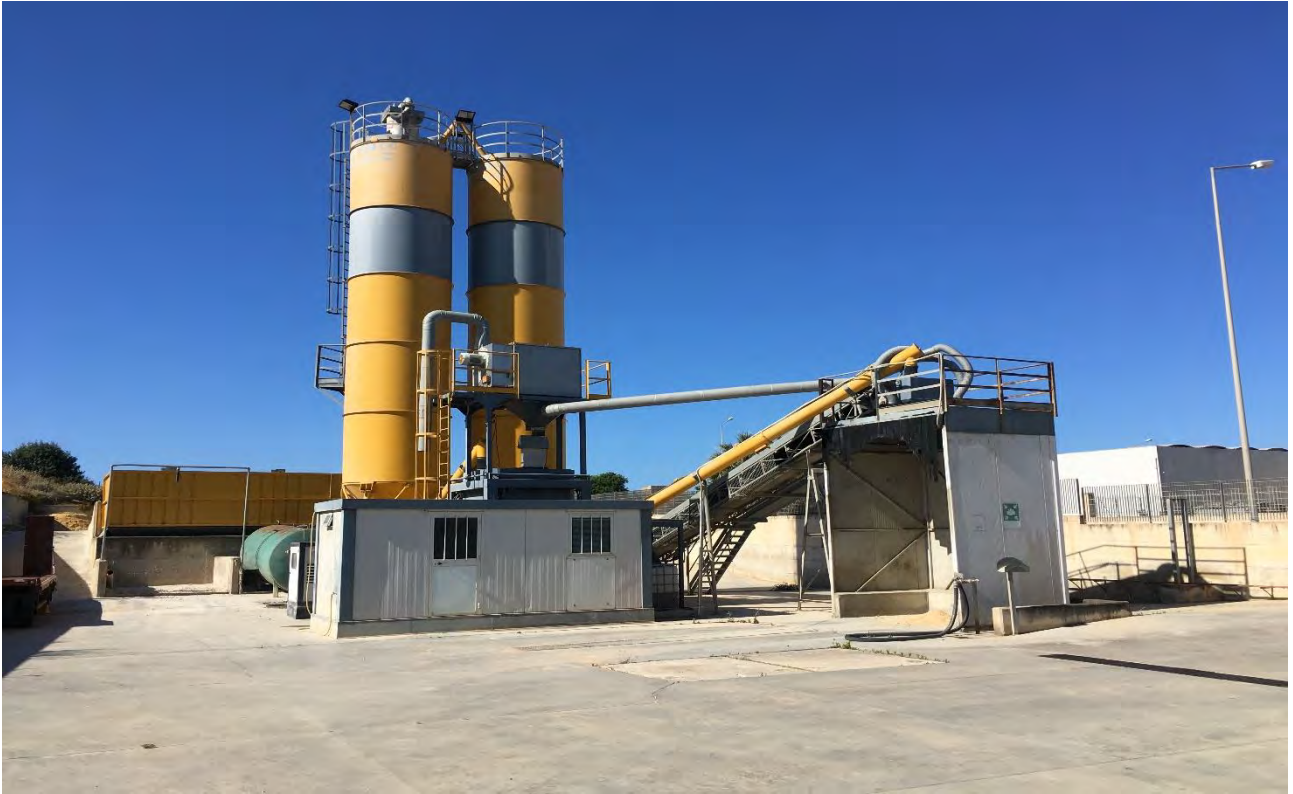
Lotto 8 Area edificabile e impianto di betonaggio – Zona Artigianale Scicli
