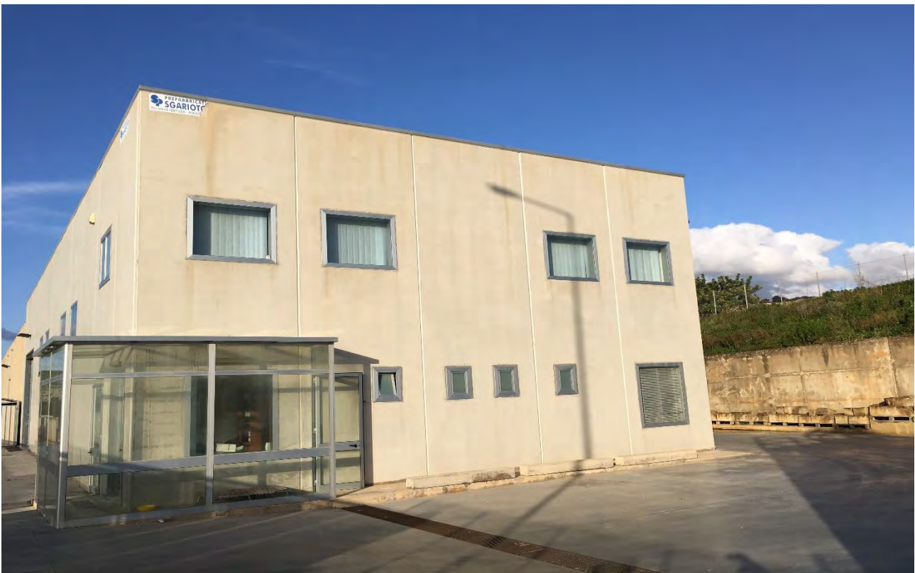
Lotto 7 Capannone Artigianale – Zona Artigianale Scicli
