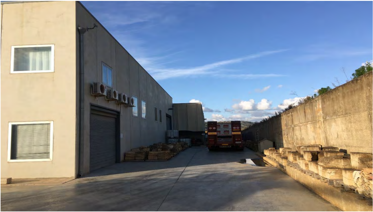
Lotto 7 Capannone Artigianale – Zona Artigianale Scicli
