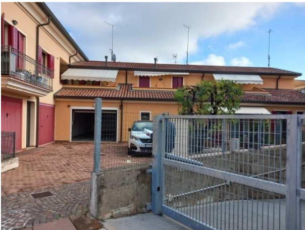
area comune lato Est
