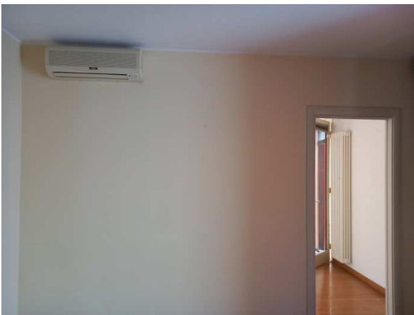
vano p. primo
