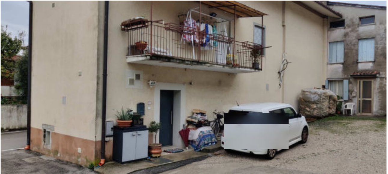
Foto n° 05 – Vista dell'entrata dalla corte comune
