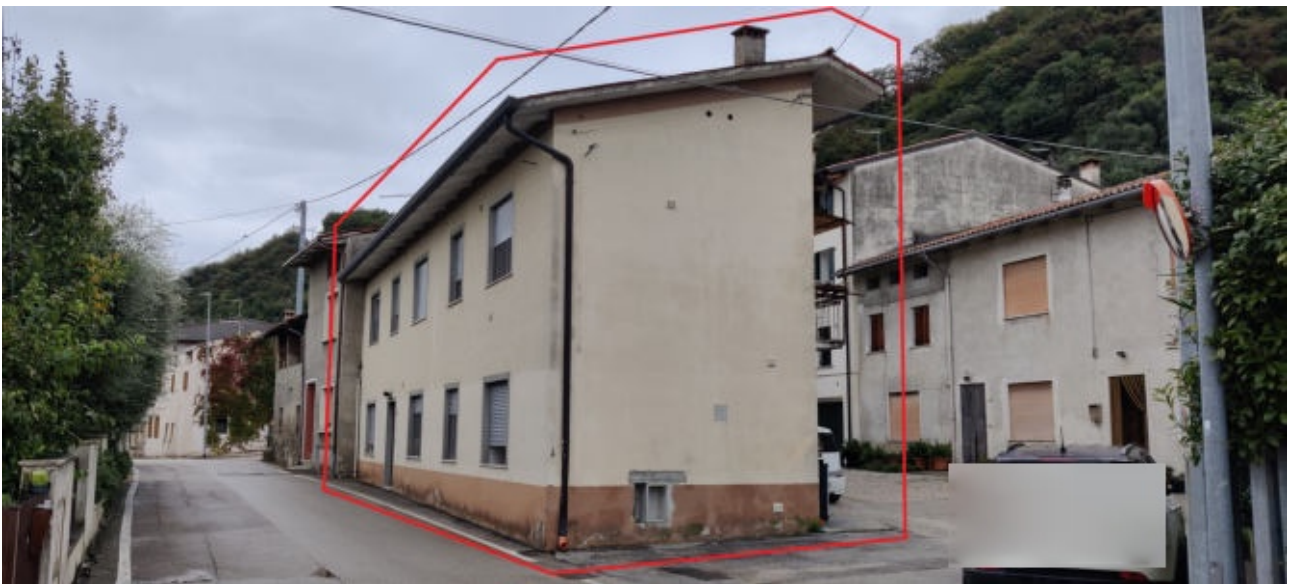
Foto n° 04 – Vista dell'abitazione da Via Scmazioni
