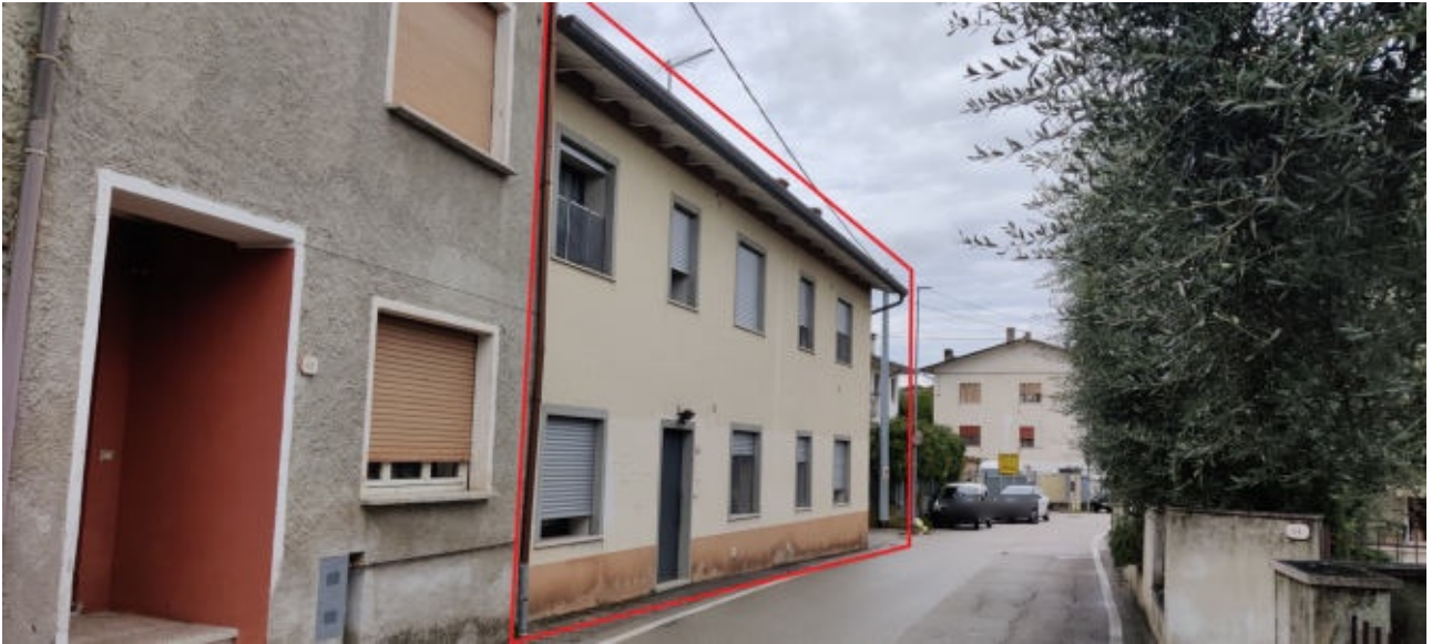
Foto n° 03 – Vista dell'abitazione da Via Scmazioni
