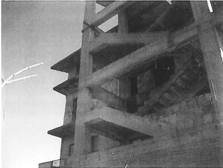
FOTO N. 9 -rampe scala e balconi-
