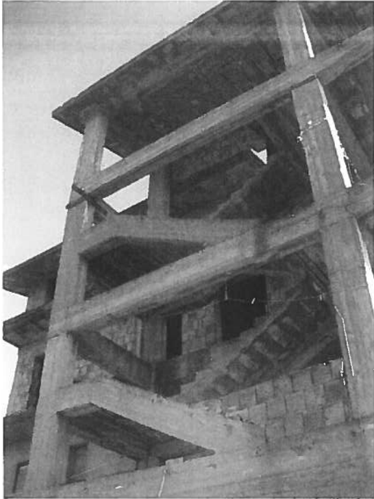
FOTO N.4 – struttura vano scala-
