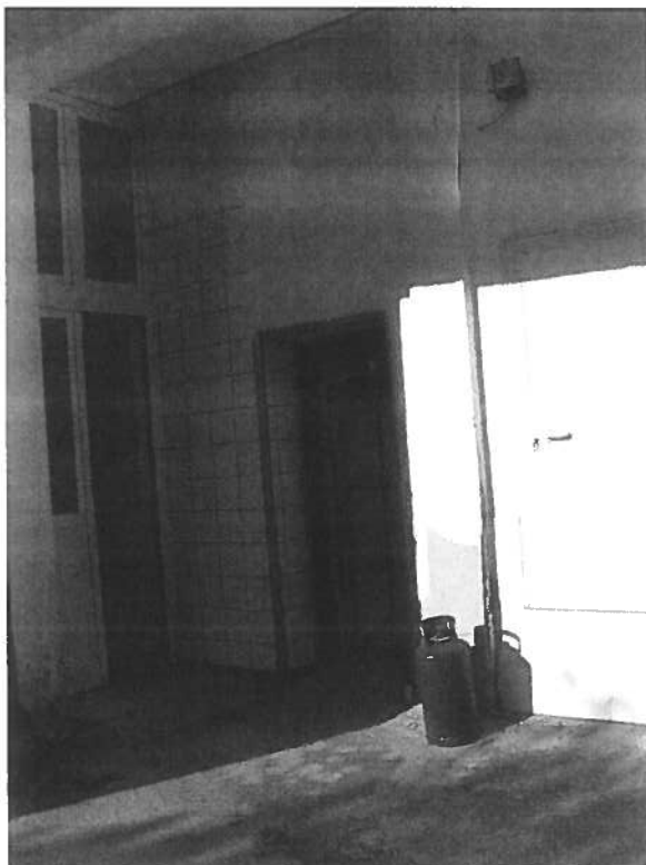
FOTO N. 27 – accessi dal lato del corpo scala -
