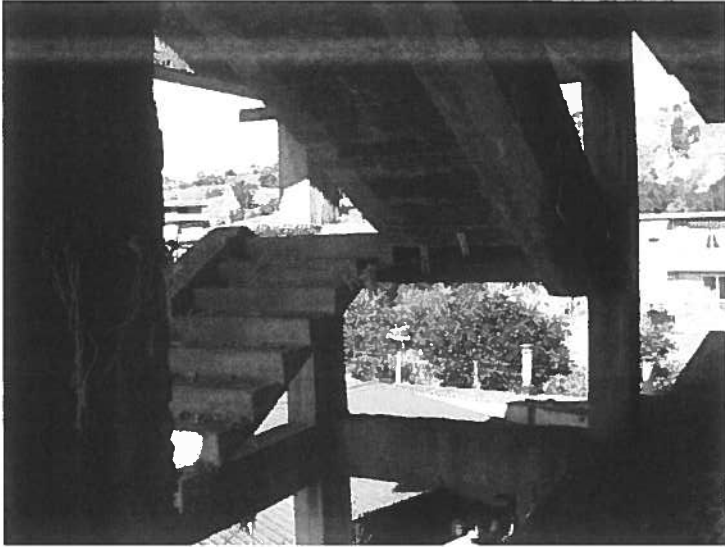
FOTO N. 8 -rampe scala esterna-
