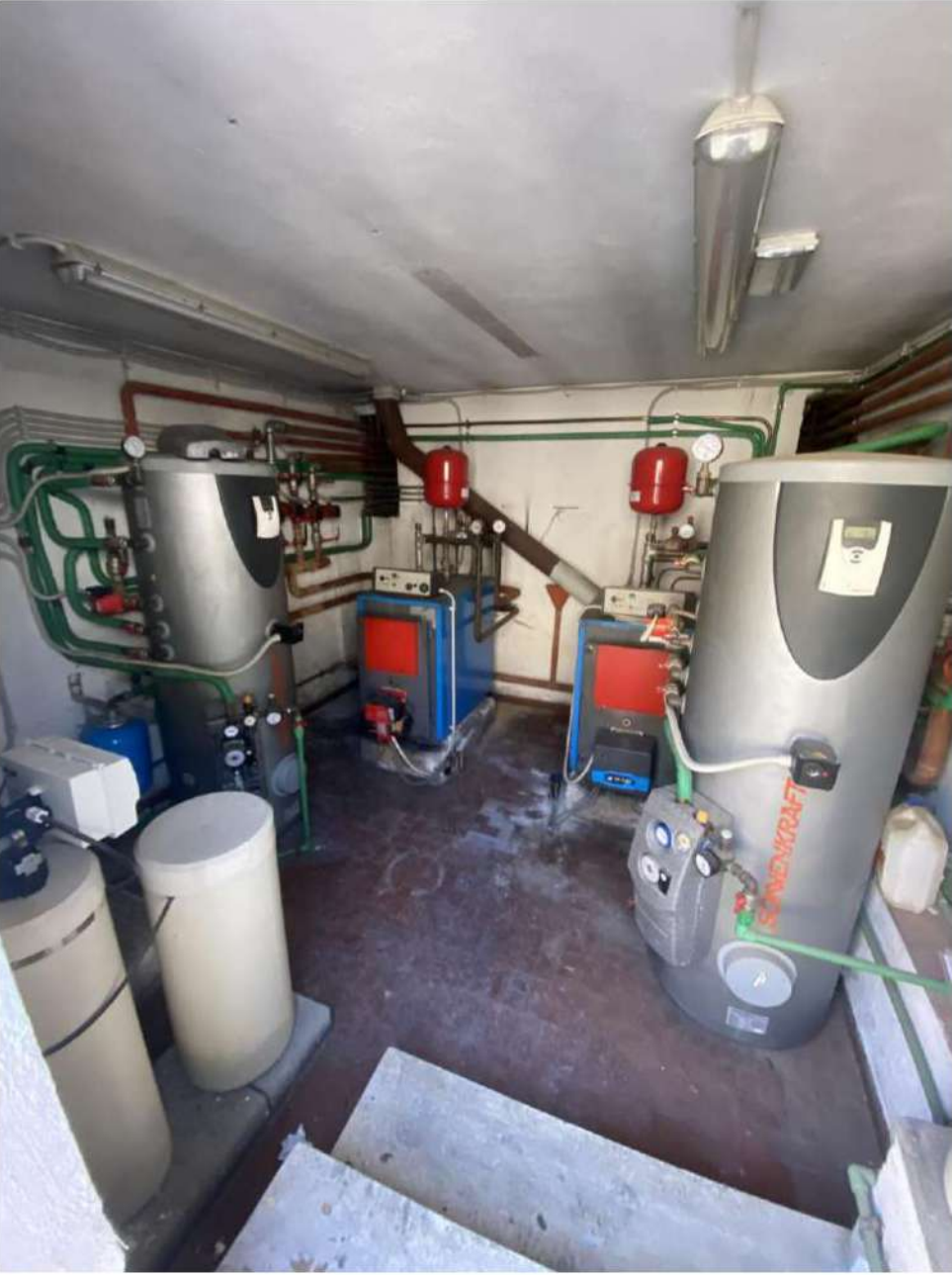
6) Locale tecnico piano S1.
