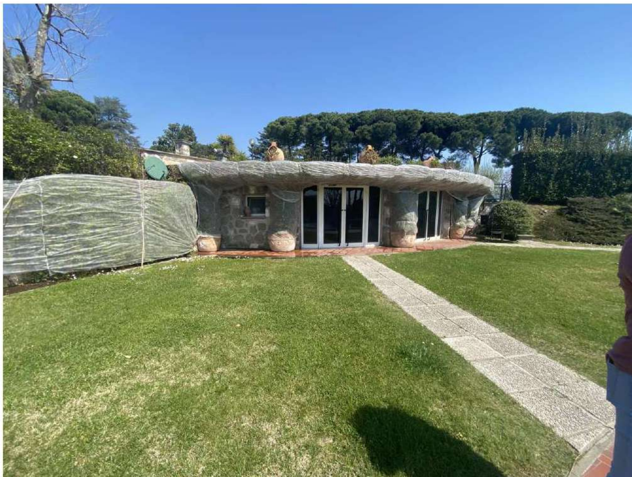
26) Vista esterno locale magazzino complesso sportivo.
