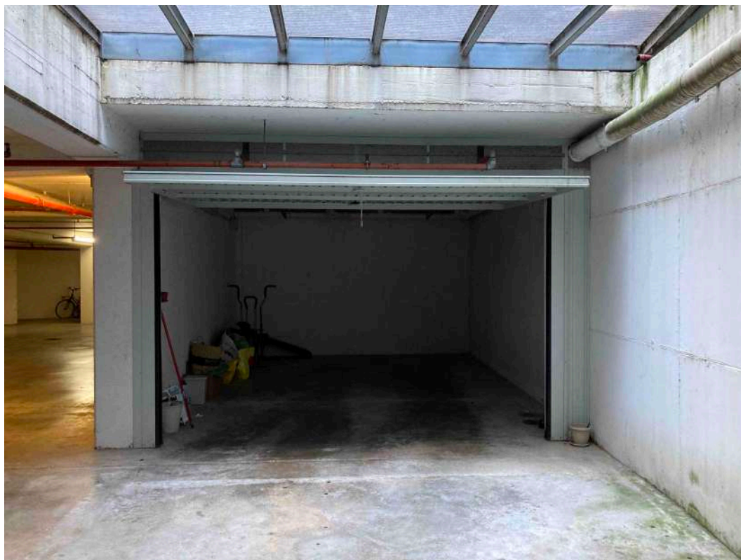
Vista dell' autorimessa sub 38
