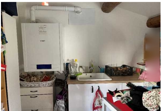
Vista del locale ripostiglio/lavanderia
